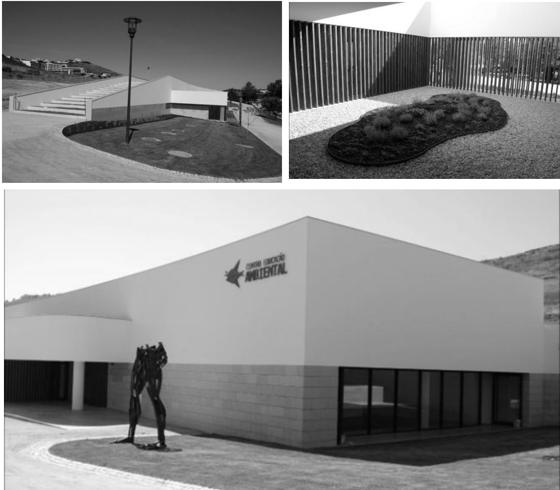
Fig. 2 – Centro de Educação Ambiental de Torres Vedras, ASPMM Arquitectos Cobertura rampeada; entrada principal; pátio interior
