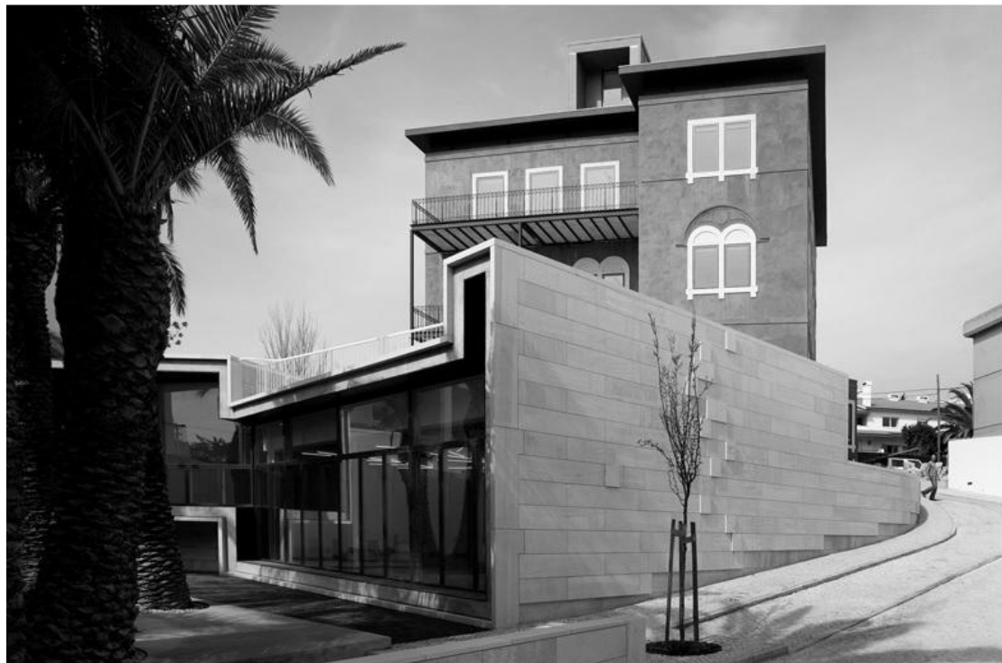
Fig. 52 – Conservatório de Música de Cascais. ARX Arquitectos. Perspectivas exteriores do confronto entre existente e construído.
