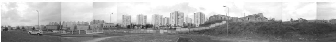
Fig. 35 – Perspectiva junto à entrada principal da Quinta pela Rua Mário Botas
