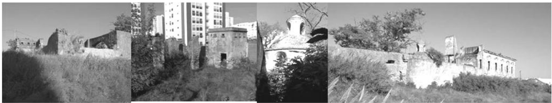
Fig. 32 – Perspectivas do Torreão, estrutura do poço, Pombal e fachada Poente da Quinta
