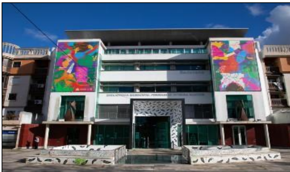
Figura 14 - Entrada da Biblioteca Fernando Piteira Santos
