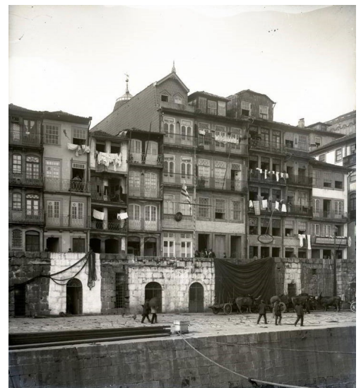
057. Muro dos Bacalhoeiros, Porto, 1910
