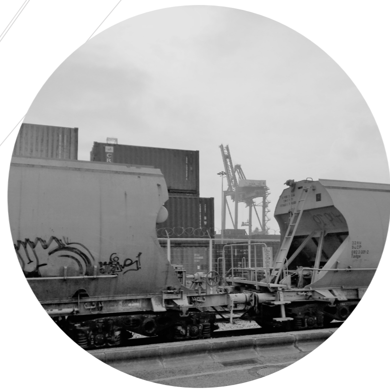
Terminal de Contentores de Xabregas 2019
