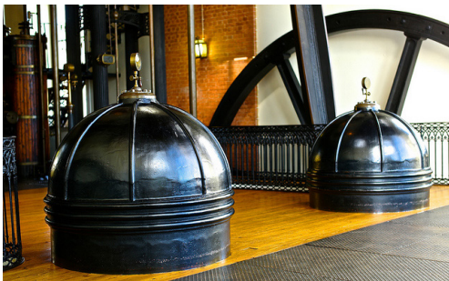
008. Estação Elevatória a Vapor dos Barbadinhos
