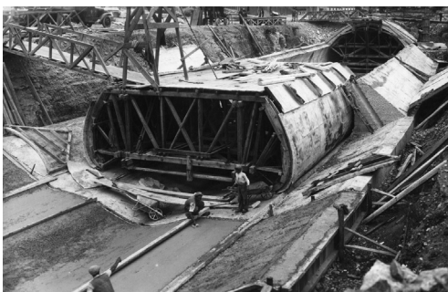
011. Construção do Caneiro de Alcântara, 1945
