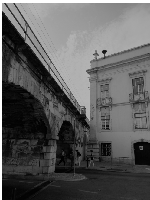
031. Viaduto de Xabregas, 2017
