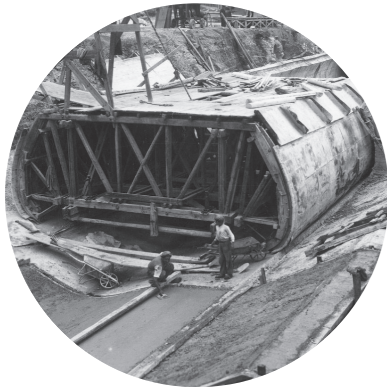
Construção do Caneiro de Alcântara 1945
