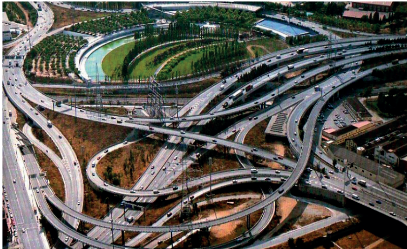
Fig.013 - Parc Nus de la Trinitat , Barcelona. Relação com a infraestrutura
