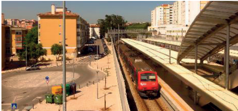
Fig.065 - Estação ferroviária do Cacém
