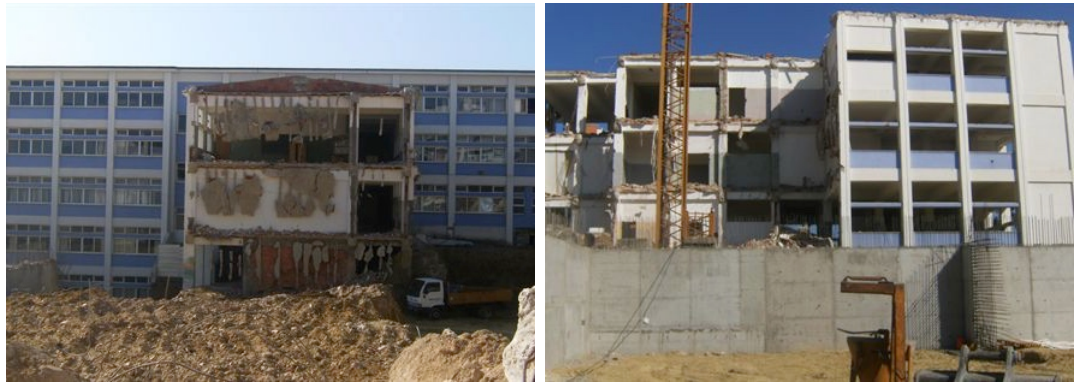
Processo de demolição e consolidação estrutural do edifício.
