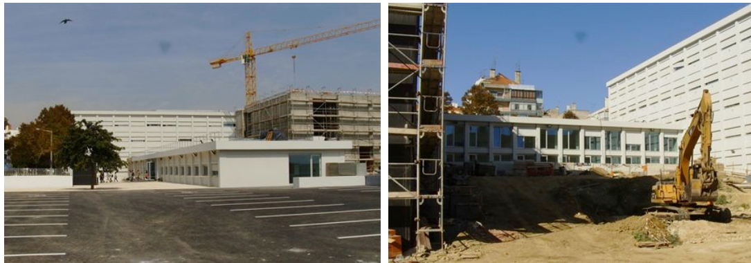
Entrada, estacionamento e pátio posterior durante o processo de construção.
