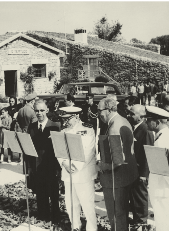
FIG. 1 Visita ao concelho de Mirandela pelo Ministro das Obras Públicas, engenheiro Arantes e Oliveira. Em Vila Verdinho com o Presidente Almirante Américo Tomás. Biblioteca e Arquivo Histórico da Economia — Secretaria-Geral do Ministério da Economia
