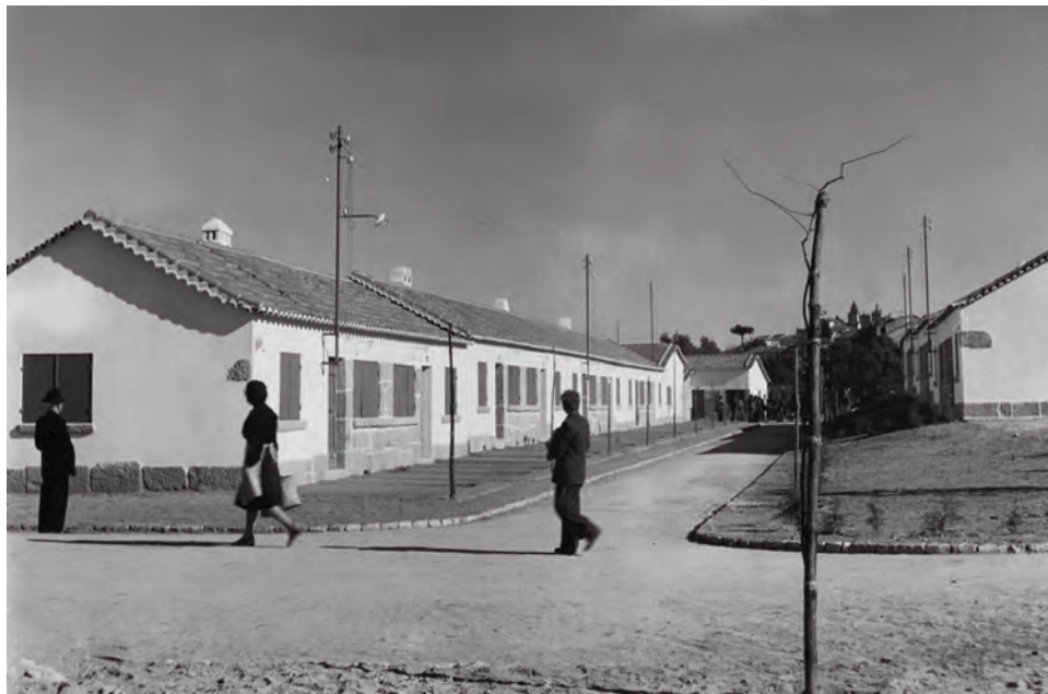
FIG. 11 Fotografia do final da construção do bairro de pobres de Viseu. SIPA/IHRU
