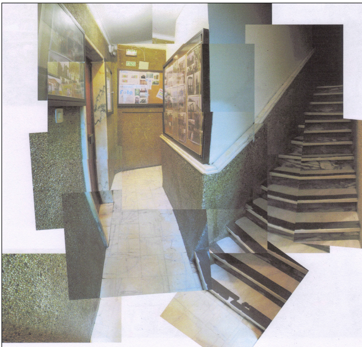
Figura 3 - Corredor do primeiro piso.
