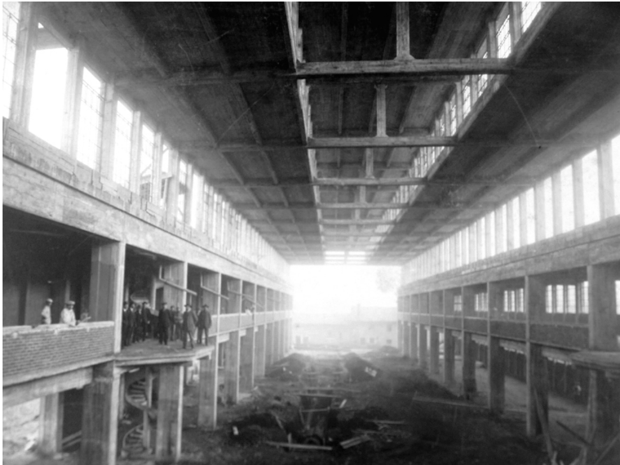
Fig. 3.34. Fábrica para a FIAT, 1911, Turim, engenheiro/arquitecto Matté-Trucco, projecto de betão armado do Bureau Technique Central Hennebique e Sociedade de Engenheiros G.-A. Porcheddu (in FH).
