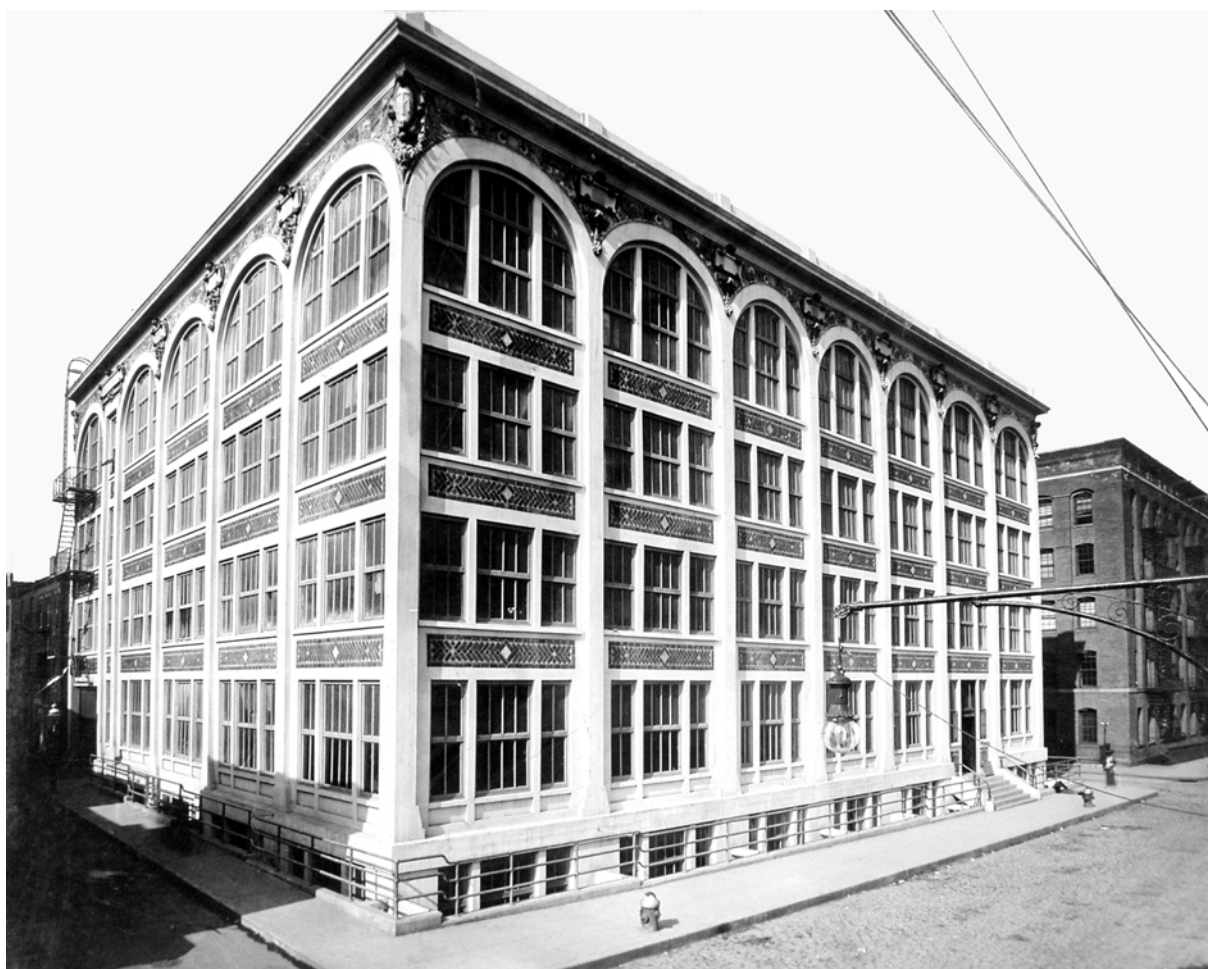
Fig. 3.19. Fábrica de contadores eléctricos em Brooklyn, Nova Iorque, 1908, arquitecto Louis Jallade e Bureau technique central de Hennebique (in FH).
