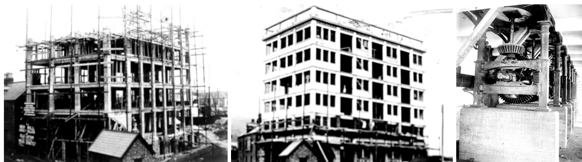
Fig. 3.16 a 3.18. Dois aspectos do edifício fabril em obra e mós mecânicas do moinho da M. Weaver & Co., em Swansea, na Escócia, 1897, Bureau technique central de Hennebique (in FH).
