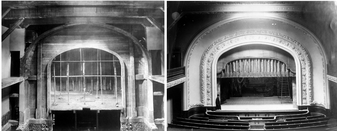
Figs. 3.12 e 3.13. Interior da sala e palco do Théâtre de la Ligue de l'Enseignement em Paris, em obra e acabado, 1908, arquitecto Charles-Paul-Camille Blondel (in FH).
