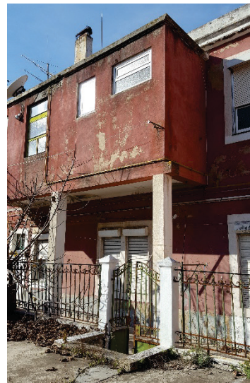
Figura 30 – Edifício das Residências
