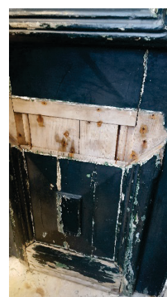
Figura 38 – pavimentos – mosaico hidráulico
