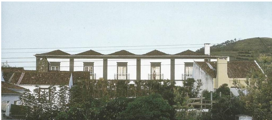
32- Casa do estilo micalense, exemplo de uma cobertura que se compõe por múltiplos telhados. Ribeira Grande, São Miguel.
