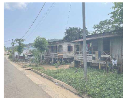
056. Sequência de habitações em construção de madeira à beira da estrada. Ilha do Príncipe.
