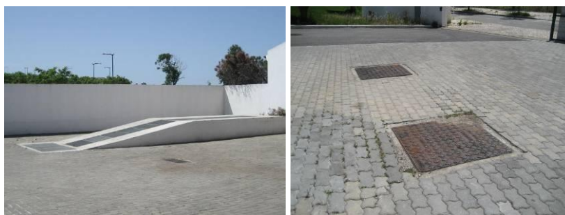
Figuras 81 e 82 – Sistema de decantação.
