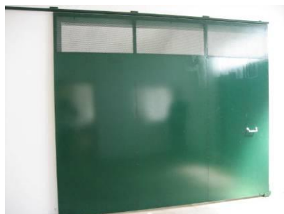
Figura 85 – Local de armazenamento de produtos químicos.
