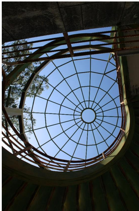
Figura 146 - Escadas metálicas de acesso subterrâneo, Panorâmico de Monsanto, © Joana Galante, 2023
