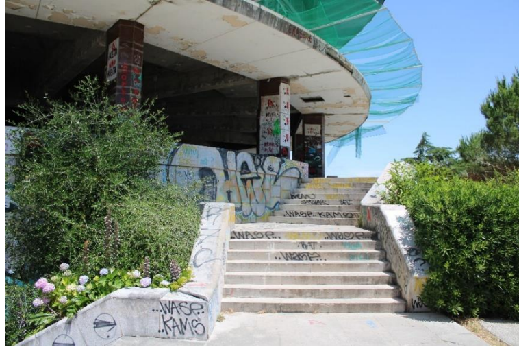
Figura 143 – Escadas de acesso Sul, Panorâmico de Monsanto, © Joana Galante, 2023
