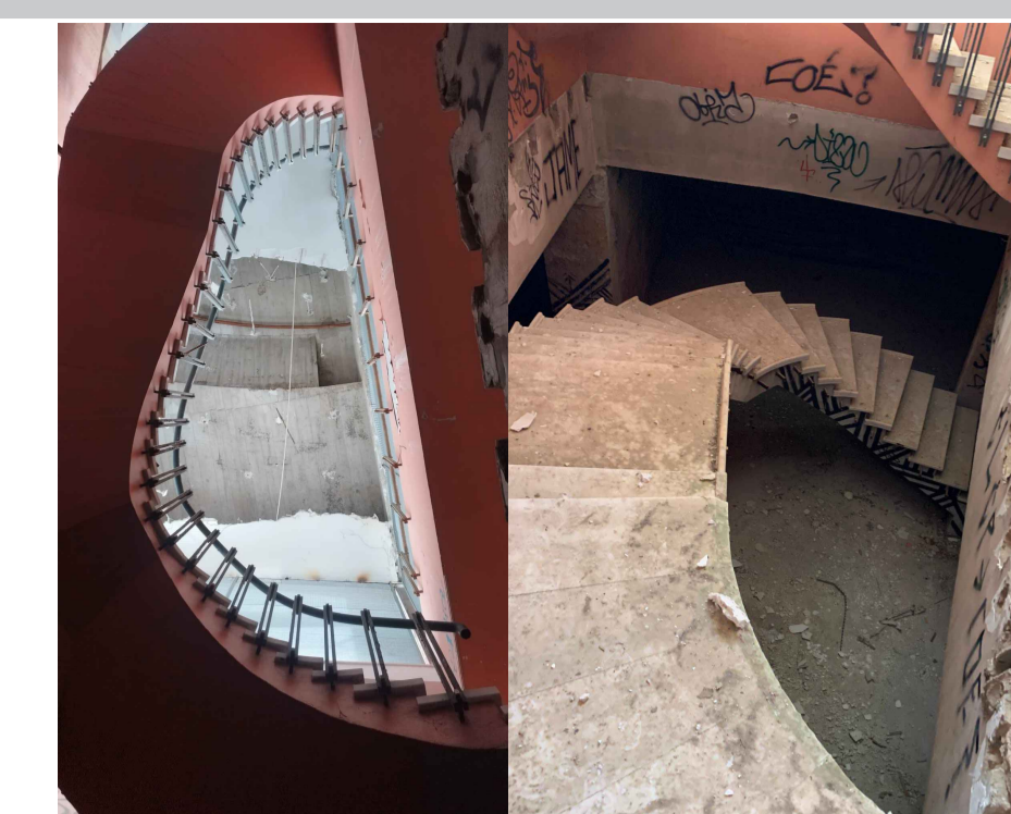
REGISTOS FOTOGRÁFICOS DAS ESCADAS
