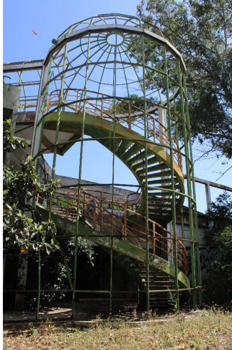
Figura 145 - Escadas metálicas de acesso subterrâneo , Panorâmico de Monsanto, © Joana Galante, 2023
