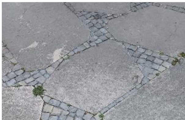
Figura 86 - Calcário preto e lajetas de Pedra natural existentes no pavimento exterior do Piso 1 © Joana Galante, 2023
