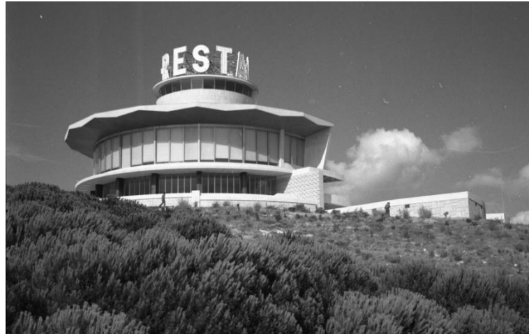
Figura 43 - 1968 - Inauguração do Restaurante Panorâmico de Monsanto (Fotografia Original)
