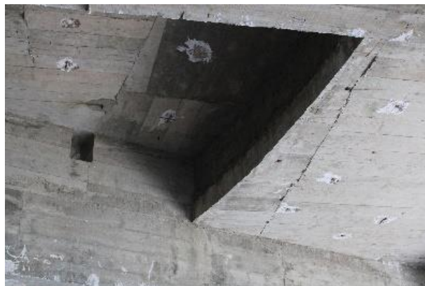
Figura 89 - Betão armado existente em grande parte dos tetos um pouco por todo o edifício © Joana Galante, 2023
