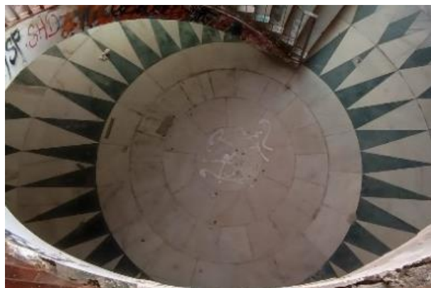
Figura 83 - Mosaico Cerâmico branco e preto existente no pavimento do Piso 1 na zona das escadas em espiral © Joana Galante, 2023
