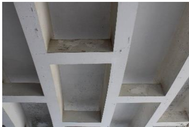
Figura 88 - Fibra de Vidro e Placas de Pladur existente no teto da entrada do Piso 1 © Joana Galante, 2023
