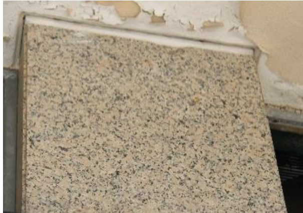
Figura 75 - Pedra Lioz existente na fachada do Piso 0 e do Piso 1 © Joana Galante, 2023
