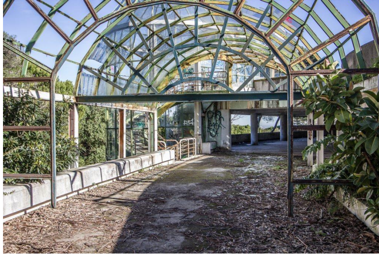
Figura 147 – Galeria de acesso subterrâneo , Panorâmico de Monsanto, © Diogo Garcia, 2019
