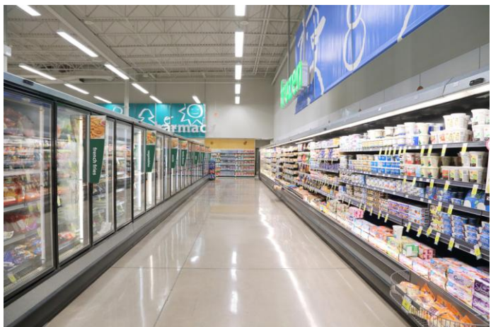
Figura 31. Iluminação Setorizada de Supermercado.
