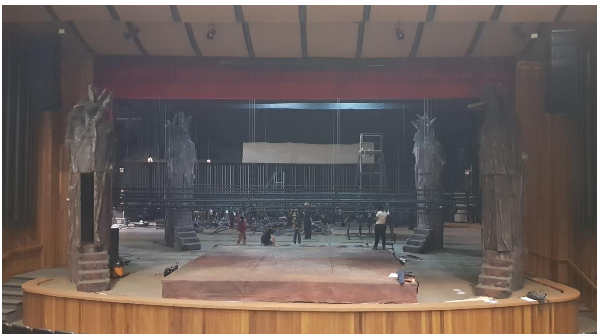
Figura 39. Instalação dos Projetores e Refletores com as Varas Abaixadas.
