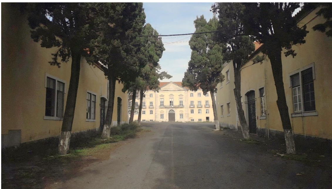
Figura 32 | Alameda entre os volumes do refeitório, a oeste, e o pavilhão gimnodesportivo, a este, do antigo quartel do Regimento de Lanceiros n.º 2 (Lisboa, Portugal).
