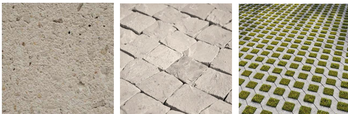
Figura 39 | Pavimento contínuo em betão UNILISBOA BRANCO, pavimento em calçada portuguesa e pavimento em grelha de enrelvamento hexagonal.
