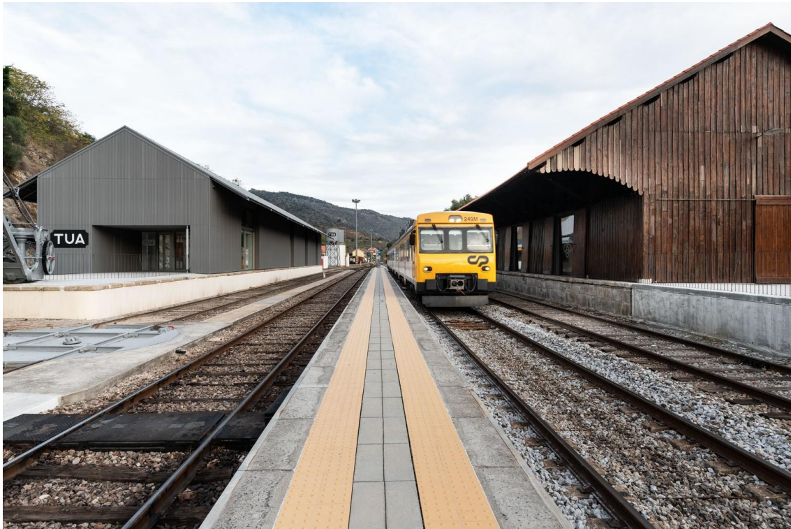
Figura 26 | Vista exterior (edifício norte, revestido a zinco, à esquerda; e edifício sul, revestido a madeira, à direita). ArchDaily. (2022, 2 de Fevereiro). Centro Interpretativo do Vale do Tua / Rosmaninho+Azevedo Arquitectos. Retirado de https://www.archdaily.com.br/908555/centro-interpretativo-do-vale-do-tua-rosmaninho-plus-azevedo-arquitectos
