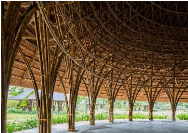
Fig. 53 Utilização de bambu para a criação de cúpulas com diâmetro de 24 metros demonstrando as capacidades elásticas deste material, Vietname, Vo Trong Nghia Architects; http://images.adsttc.com/media/images/5660/a121/e58e/ce20/b400/0416/large_jpg/pic11_largestructure02_OKI.jpg?1449173273
