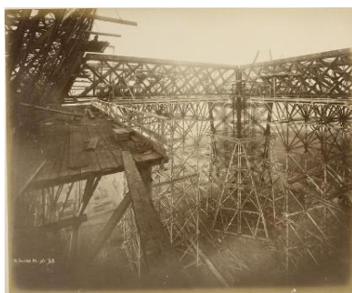
Fig. 48 Montagem dos apoios à construção da Torre Eiffel, Paris; http://static.messynessyctic.com/wp-content/uploads/2015/01/eiffel8.jpg
