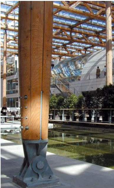
Fig. 91 Conexão metálica entre pilar de madeira e pavimento de pedra, Academia de Formação Heme, Alemanha, 1992-1999, Perraudin Architecture; http://www.perraudinarchitecture.com/projets/heme_allemanne/heme_allemanne.htm
