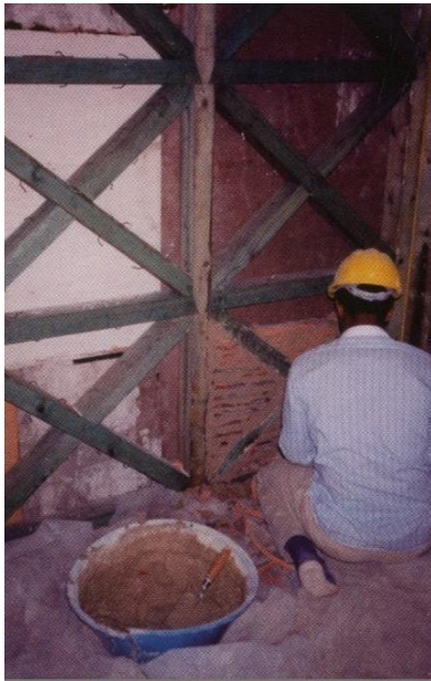
Fig. 44 Frontal com Cruz de St. André em execução numa obra de reabilitação; (Garcia, 2008 p. 14)
