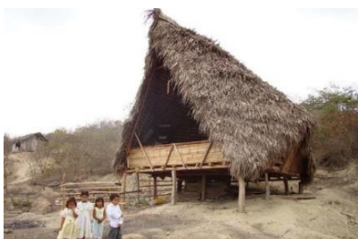
Fig. 10 Escola construída com recurso a materiais e técnicas locais no Equador; http://assets.inhabitat.com/wp-content/blogs.dir/1/files/2012/01/Al-bordE-Local-Materials-Active-School-Natural-Materials-Escuela-Nueva-Esperanza-Ecuador-School-1.jpg
