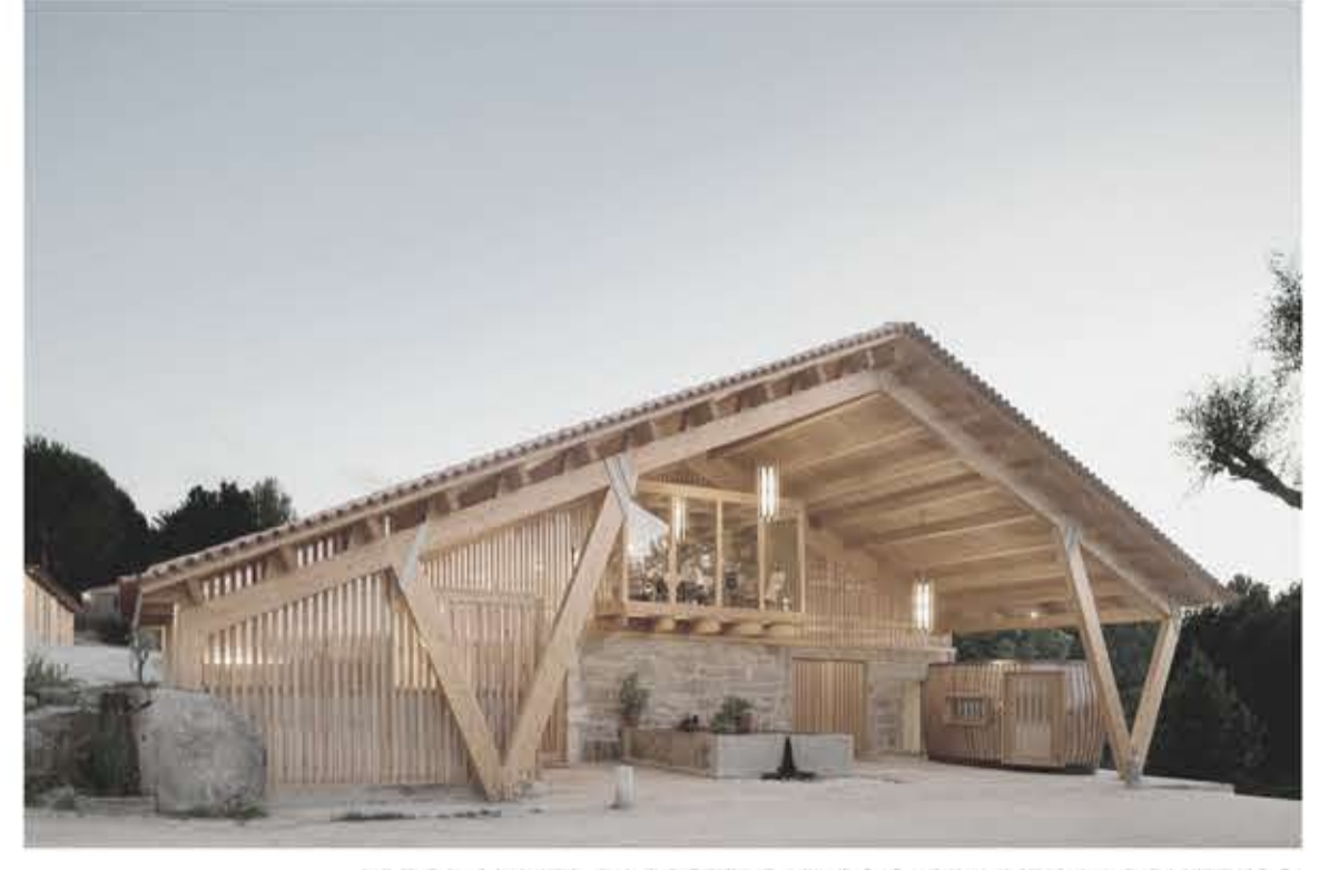
ADEGA QUINTA DA TORRE; CARLOS CASTANHEIRA ARQUITETOS
