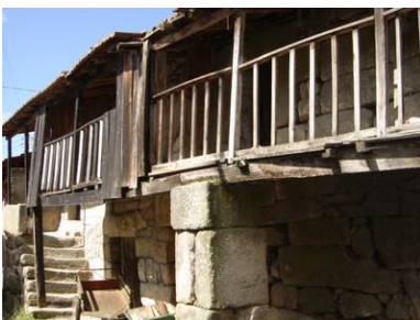
Fig. 102 Situação comum em que as paredes são realizadas em pedra local e a madeira é utilizada nos pavimentos e cobertura;
