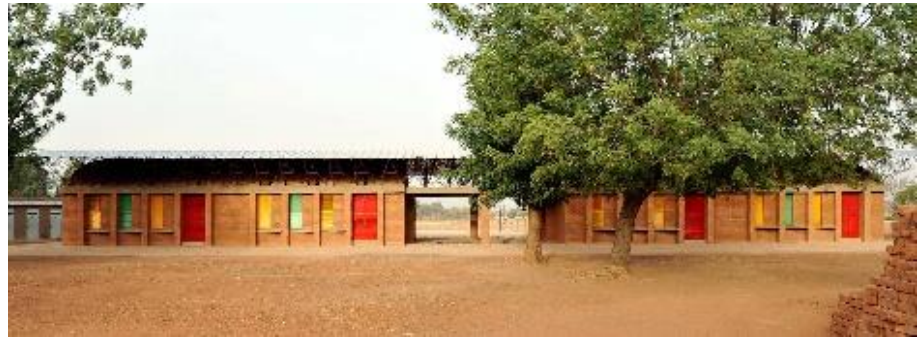
Fig. 17 Ampliação de uma escola recorrendo à autoconstrução e aos blocos de adobe fabricados localmente como material de construção, Burkina Faso, Kéré Architecture; http://www.kere-architecture.com/projects/school-extension-gando/
