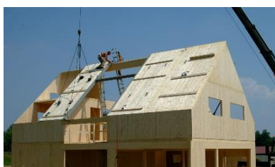
Fig. 47 Construção de habitação familiar construída com painéis de madeira; http://www.biovilla.eu/wp-content/uploads/2014/12/MONTAGE-PMC-TER.jpg
