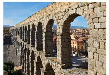
Fig. 19 Utilização de Blocos de granito no Aqüeduto de Segóvia, Espanha (séc. I-II); https://upload.wikimedia.org/wikipedia/commons/b/b3/Aqueduct_Segovia_2_2012.jpg
