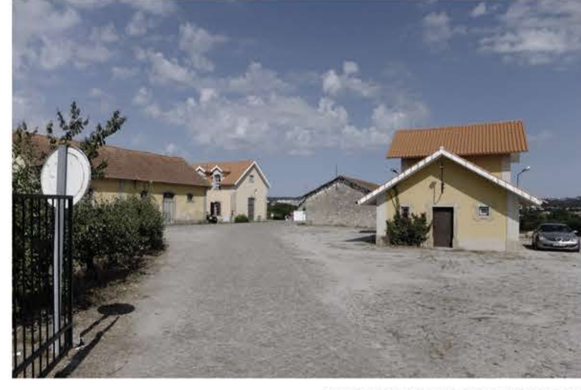
EDIFÍCIOS DE APOIO NA QUINTA NORTE
