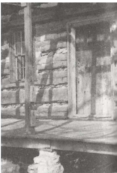
Fig. 70 Alpende de entrada elevado com recurso à sobreposição de pedras; (Bahamón, et al., 2008 p. 17)
