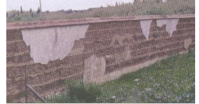
Fig. 33 Muro de Taipa em divisão de propriedades; (Rocha, 2015 p. 95)
