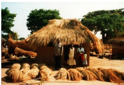
Fig. 13 Utilização de colmo na cobertura de edifícios tradicionais de habitação na Zâmbia; http://images.adsttc.com/media/images/556e/fed2/e58e/ce95/6600/022f/large_jpg/Zambia_thatch_sto_red_in_bundles_being_applied_to_roof_(submitted_by_zambiaarchitecture).jpg?1433337546
