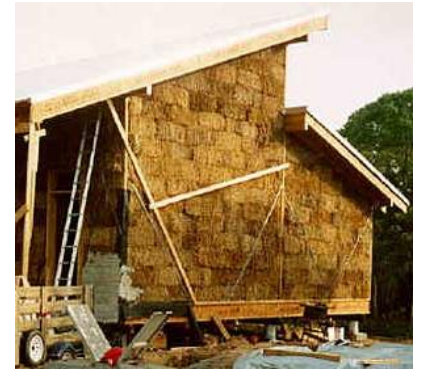
Fig. 93 Construção de edifício requerendo ao Sistema Nebraska; http://www.earthhomesnow.com/images/straw-bale-house.jpg
