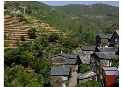
Fig. 104 Utilização de materiais locais para a construção das habitações (xisto e ardósia), Piódão; Fotografia do Autor;
