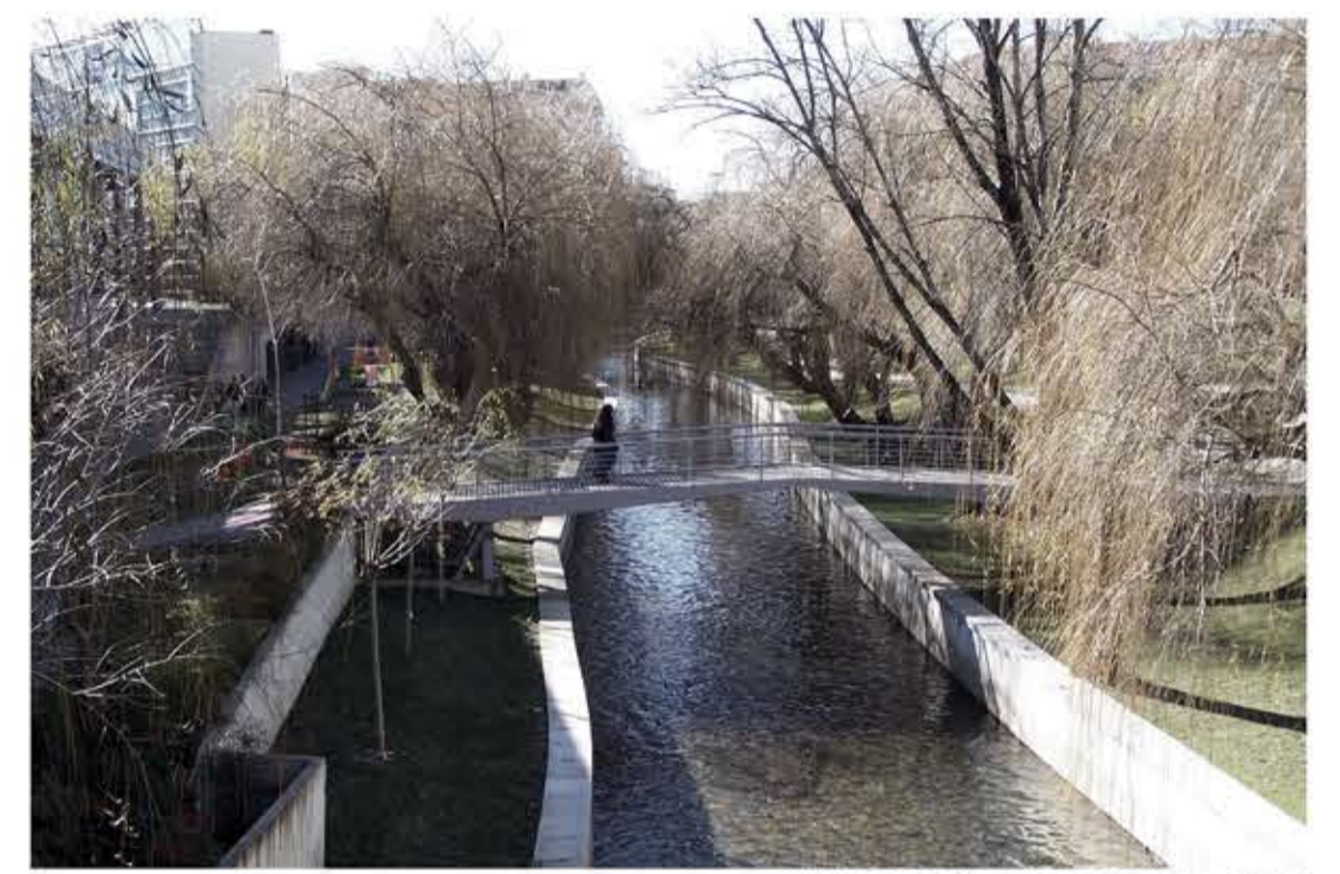
INTERVENÇÃO JUNTO AO RIO PAVIA
