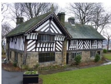
Fig. 45 Construção medieval utilizando pedro no nível térreo e madeira para os pisos superiores e cobertura; http://static.panoramio.com/photos/large/49423337.jpg
