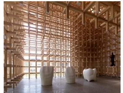
Fig. 88 Utilização de um sistema tradicional japonês de entalhes, GC Prostho Museum Research Center, Japan, Kengo Kuma and Associates; http://images.adsttc.com/media/images/5004/e0c1/28ba/0d4e/8d00/0ad2/large_jpg/stringio.jpg?1414027315
