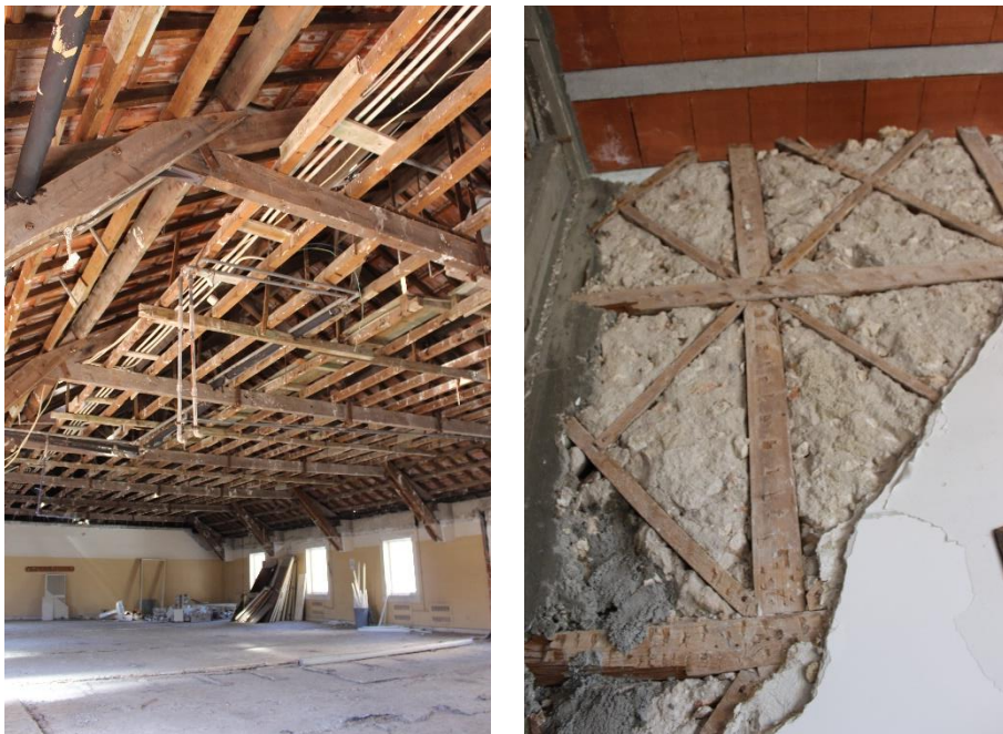
Figura 39 - conjunto de fotografias das intervenções no Hospital Militar de Belém
