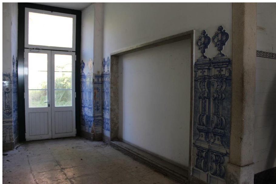
Figura 53 - Azulejos existentes a manter; Acesso ao pátio
