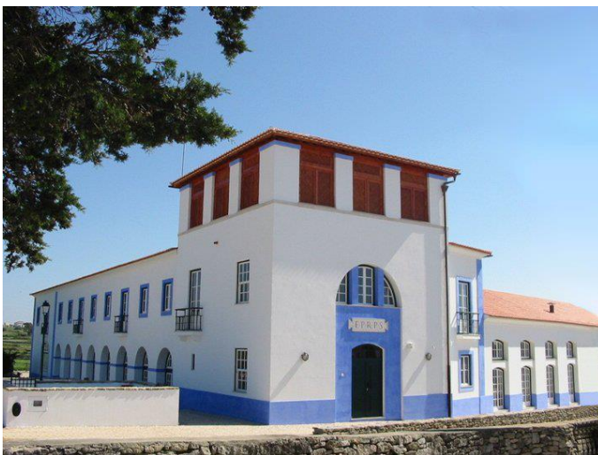
Figura 12 - Fachada da EPRPS. Fonte: EPRPS 2019
