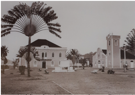
Fig 26 | Edifício de Administração de concelho (1958) LOUREIRO, João – Postais Antigos de São Tomé e Príncipe. Lisboa: João Loureiro e Associados, (1999).
