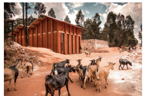
Fig 91 | Biblioteca de Muyinga, Burundi | Fonte: Fotografia de BC Architects
