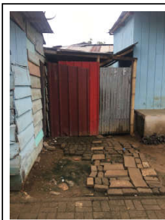
Fig A. 28 | Condições dos arruamentos e frentes de rua | Fonte: Fotografia de Baptista Lopes
