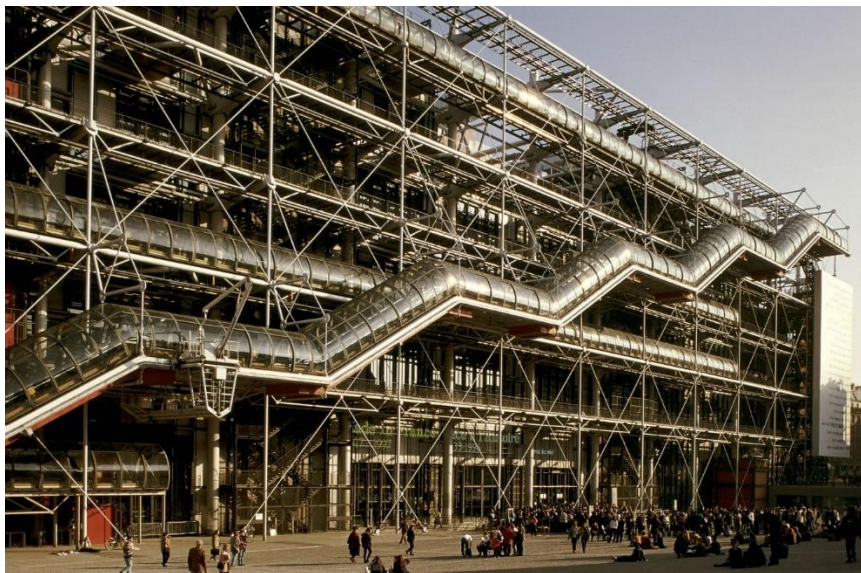
12. Fotografia da fachada poente do Centro Pompidou e a relação com a praça.
