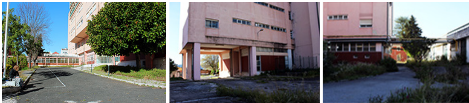
Figura 23 - Envolvente do edifício do século XX.
