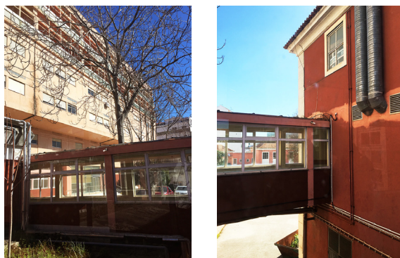
Figura 19 - Passagem de ligação entre os dois edifícios.
