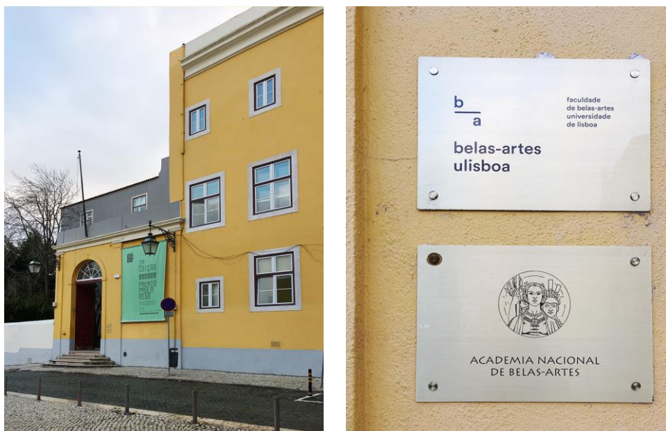
FIGURA 43: Fachada atual da Faculdade. Placas de identificação do edifício.
