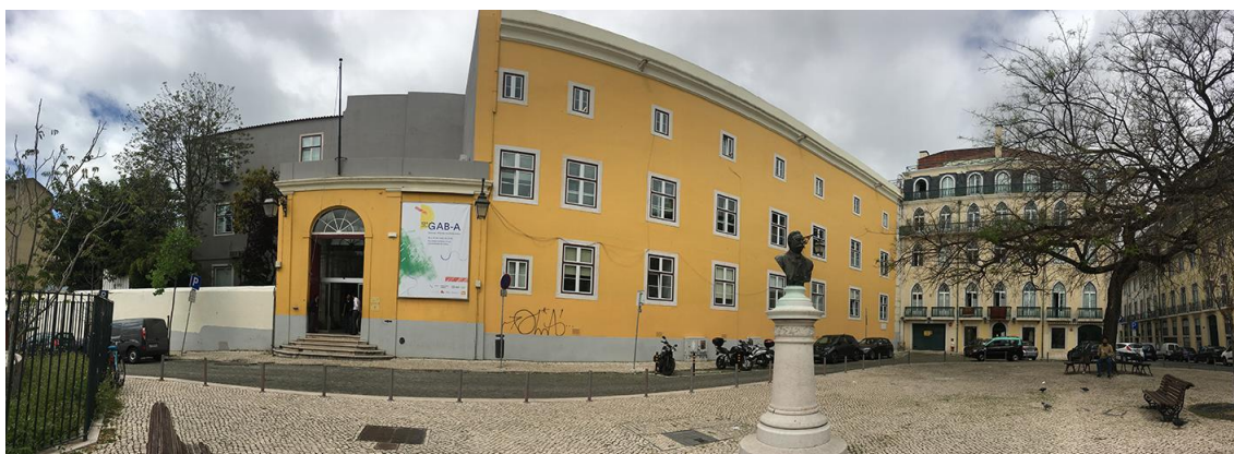
FIGURA 39: Fachada atual da FBAUL.
