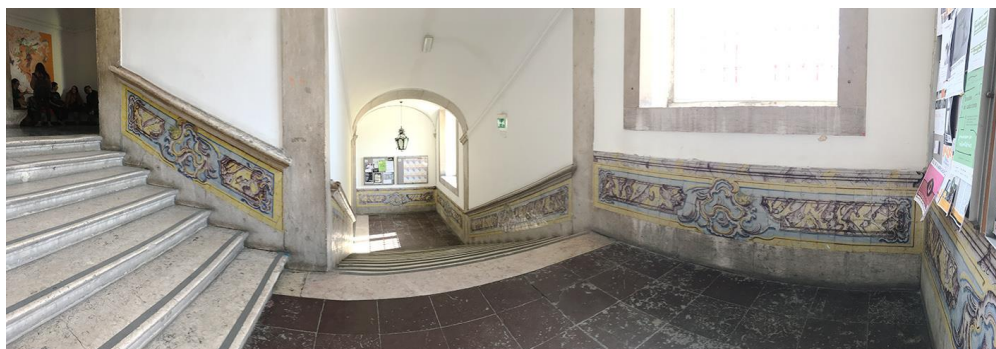
FIGURA 41: Escada principal com revestimento em azulejos pombalinos.
