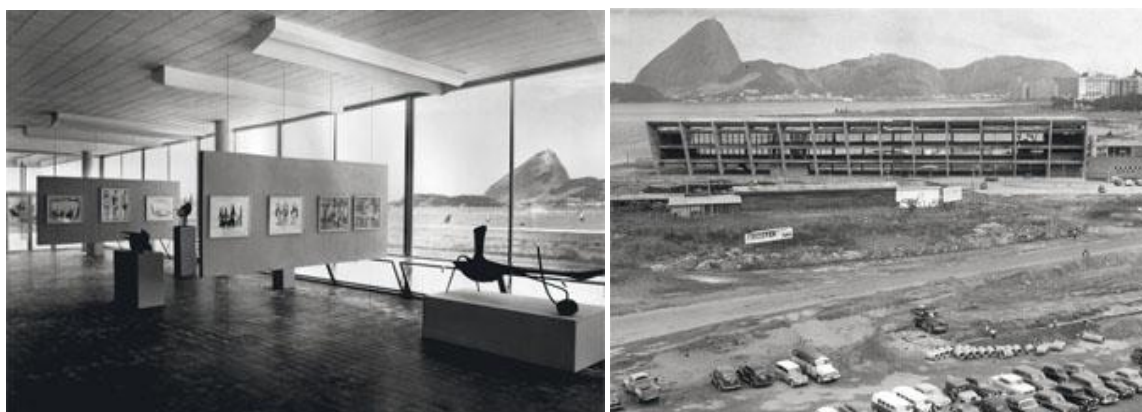
Ilustração 28 – Bloco Escola (esquerda) e Bloco de Exposições em construção, 1958. Fonte: www.mamrio.org.br/museu/apresentação
