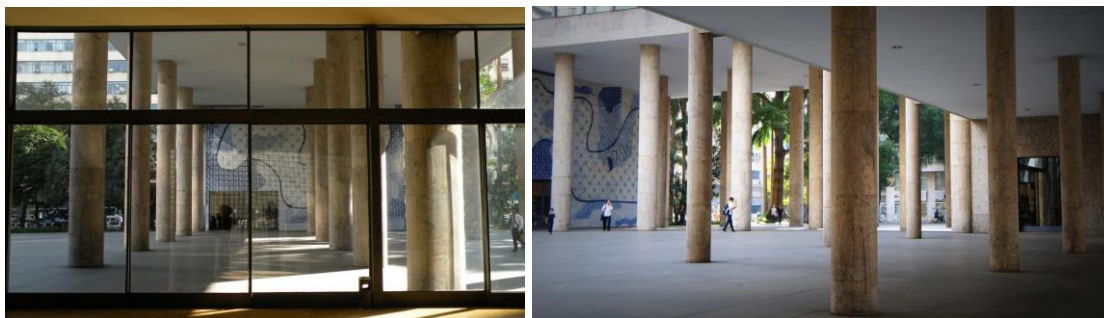
Ilustração 11 – As relações interior e exterior e a presença do edifício na praça. Fonte: O autor e Cláudio Zeiger.
