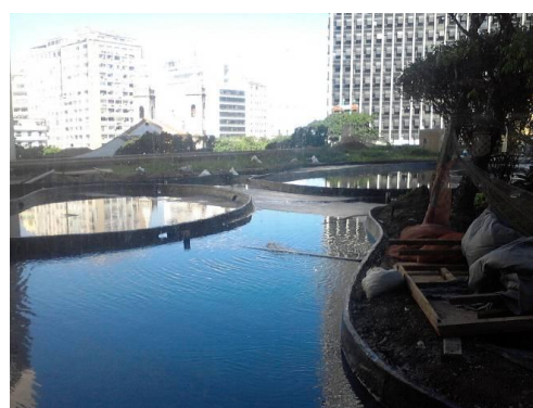
Ilustração 21 – Terraço-jardim em obras de impermeabilização. Fonte: O autor.
