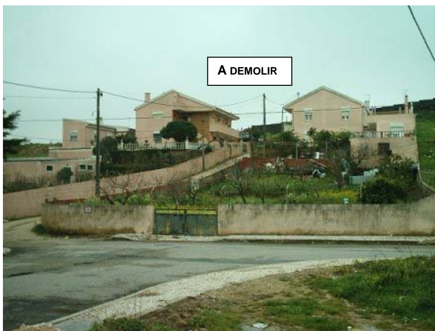
Figura 10 – Edificações a demolir ao Km 1+150.
