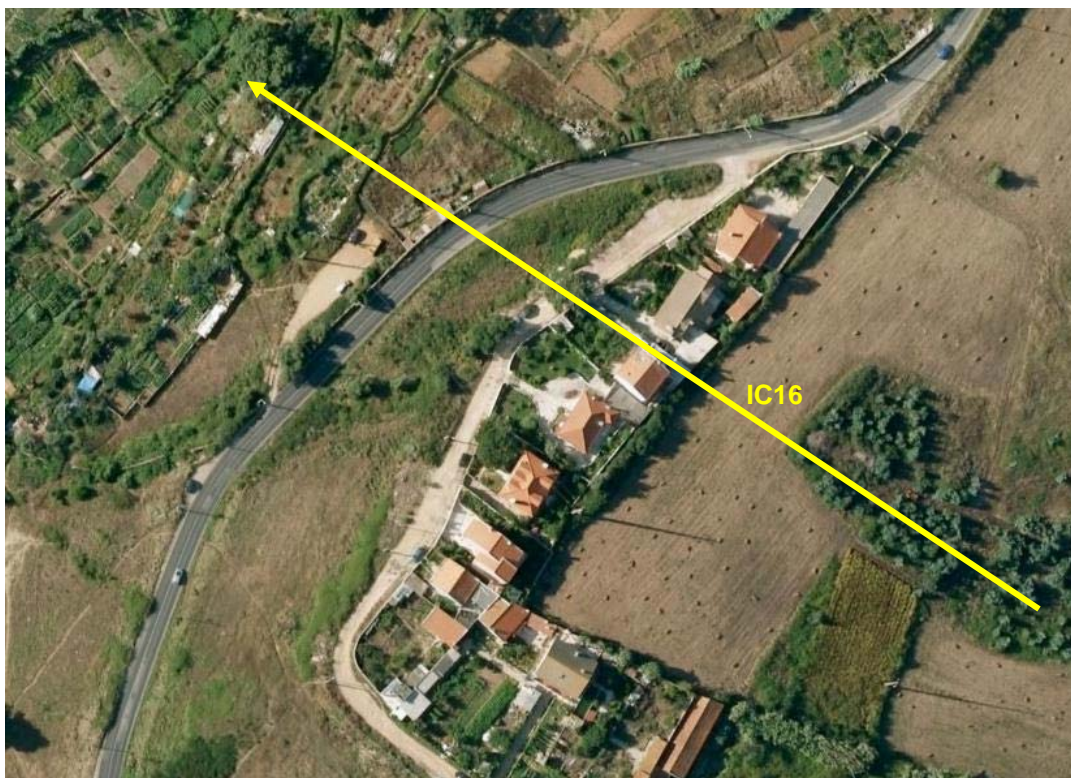
Figura 15 – Imagem aérea das construções abrangidas pelo Nó de Aqualva/Cacém.
