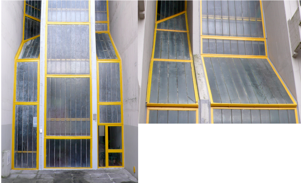
Figura 8 | Imagens das Torres de Alfragide. Fonte: Própria
