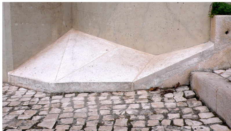
Figura 9 | Exterior da estação de Metro de Carnide. Fonte: Própria
