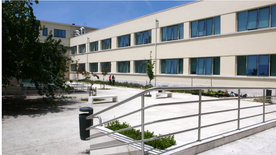
Figura 38 | Janelas da ala noroeste vistas do pátio interior. Fonte: Própria
