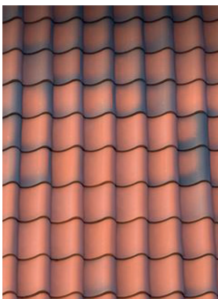
4.19 Fotografia da telha da House on Fano, Lenschow & Philmann
