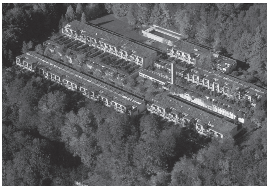
3.16 Fotografia aérea de Siedlung Halen
