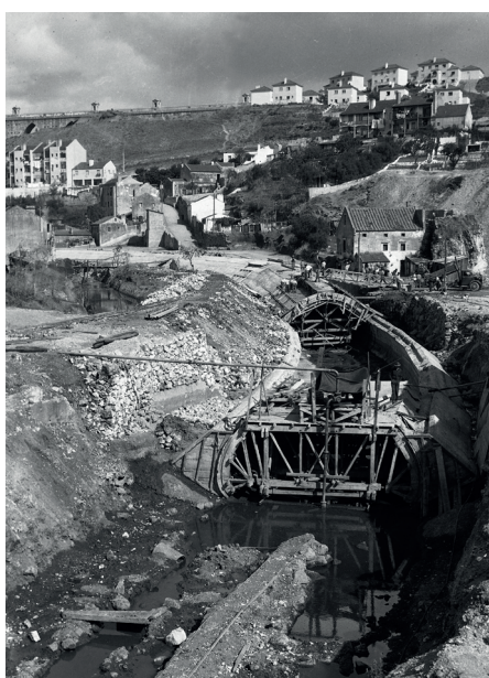
1.3 Obras de canalização e cobertura da ribeira de Alcântara
