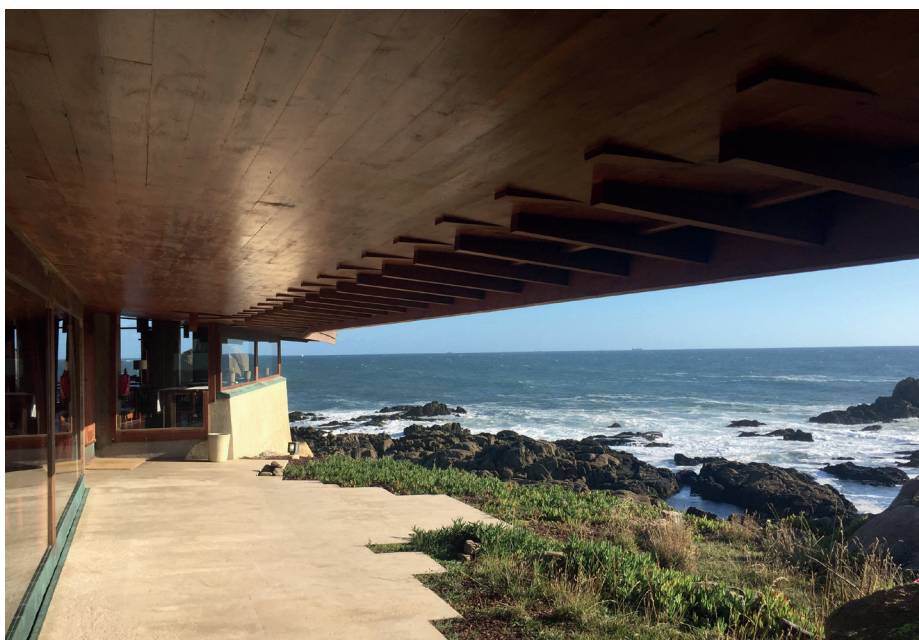
4.8 Fotografia do pormenor do remate da cobertura
