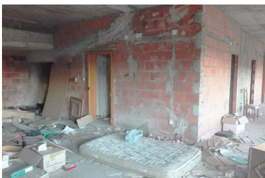
Fig.14: O Espaço C3 antes das obras de reabilitação Clube, 2017
