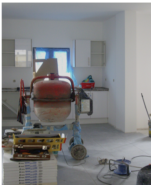
Fig.19: “Espaço Jovem” em obras, outubro 2018 Investigadora, 2018
