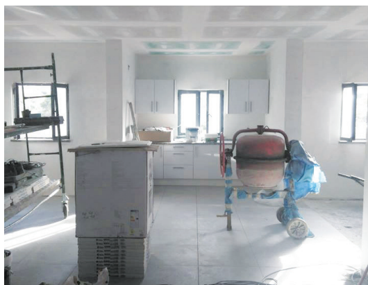
Fig.44: Estado atual das obras do "Espaço Jovem" Teresa Simões, 2018
