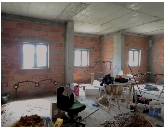
Fig.43: Início das obras do "Espaço Jovem", em maio João Coelho, 2018
