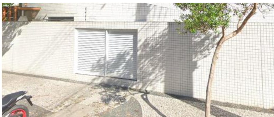
Figura 208 - Nova lixeira do edifício Oliveira Santos. Fonte: Acervo pessoal da autora (2023).
