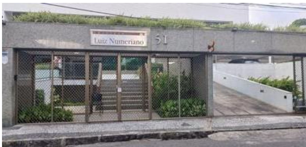
Figura 199 – Acesso ao edifício Luiz Numeriano sem espaço de espera, com antecâmara e interfone. Fonte: Acervo pessoal da autora (2023).
