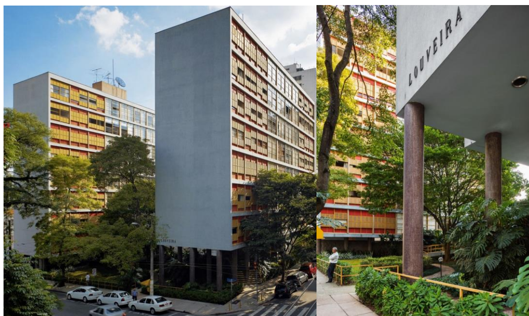
Figura 13 - Vistas atuais do edifício Louveira. Fonte: Nelson Kon (2022).
