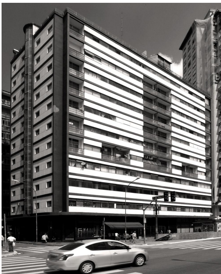
Figura 9 - Janelas em fita. Fonte: núcleo Docomomo São Paulo. Foto: André Marques (2021).
