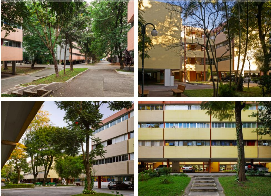
Figura 29 - Conjunto Habitacional Zezinho Magalhães Prado na atualidade. Fonte: Nelson Kon (2018).
