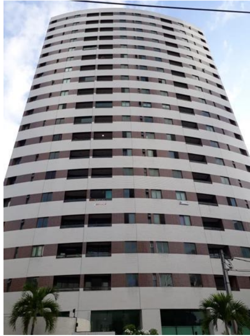
Figura 249 - Edifício Sobrado Gilberto Freyre. Fonte: Acervo pessoal da autora (2023).
