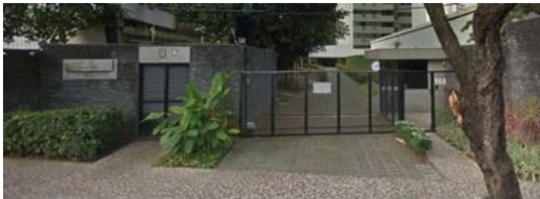
Figura 227 - Caixa mural do lote recuada do edifício Maria Inês, com recuo insuficiente para veículos e localização da lixeira. Fonte: Acervo pessoal da autora (2023).
