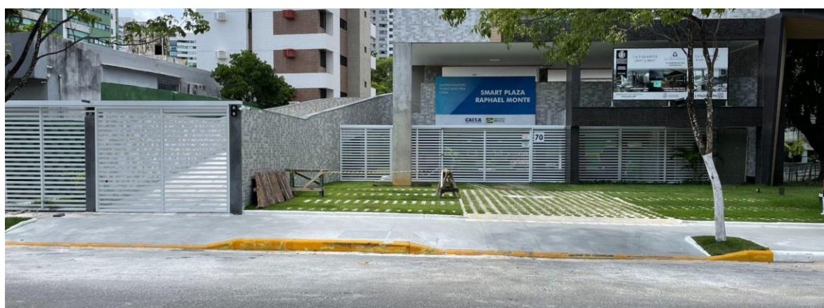
Figura 261 - Detalhe da lixeira e do acesso de veículo do pavimento vazado sem recuo do edifício Raphael Monte. Fonte: Acervo pessoal da autora (2023).
