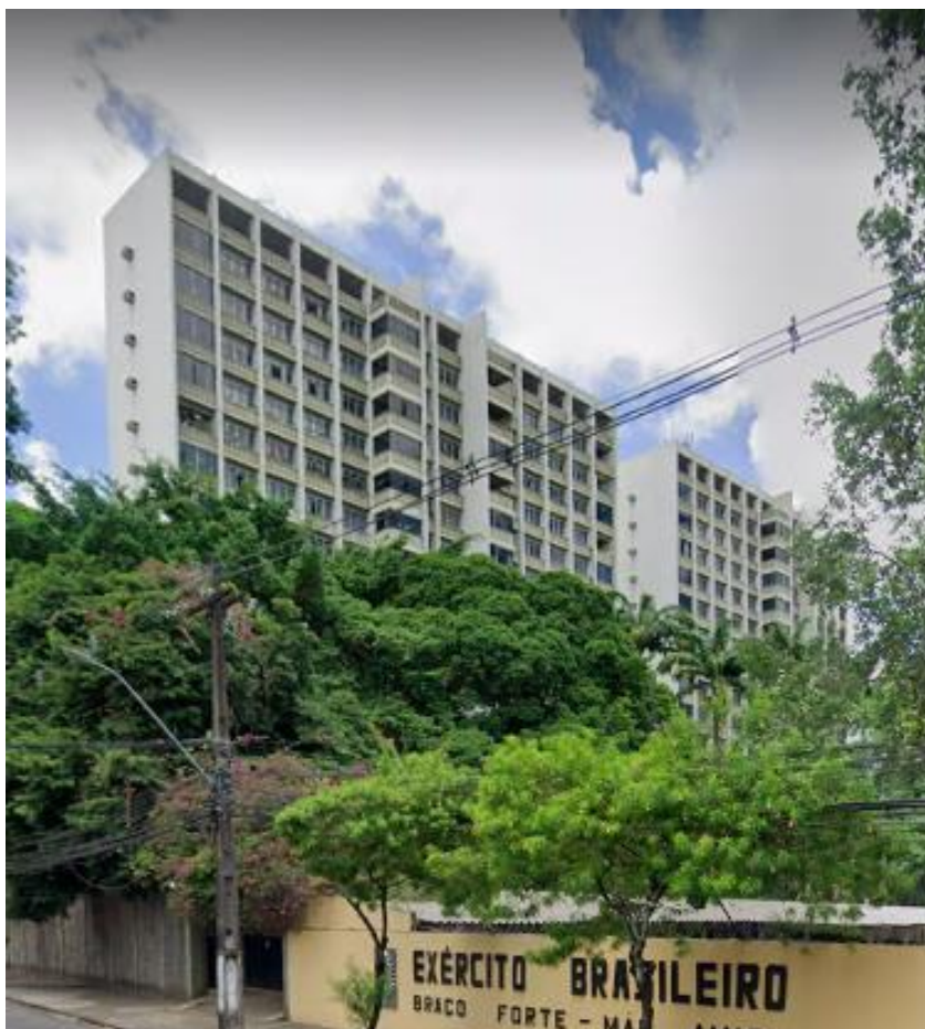
Figura 104 - Estado atual do edifício Casa Grande Santanna. Fonte: Acervo pessoal da autora (2023)
