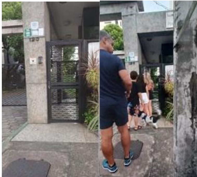
Figura 292 – Guarita e calçada do lote dos edifícios Pedra do Reino e Ariano Suassuna.
