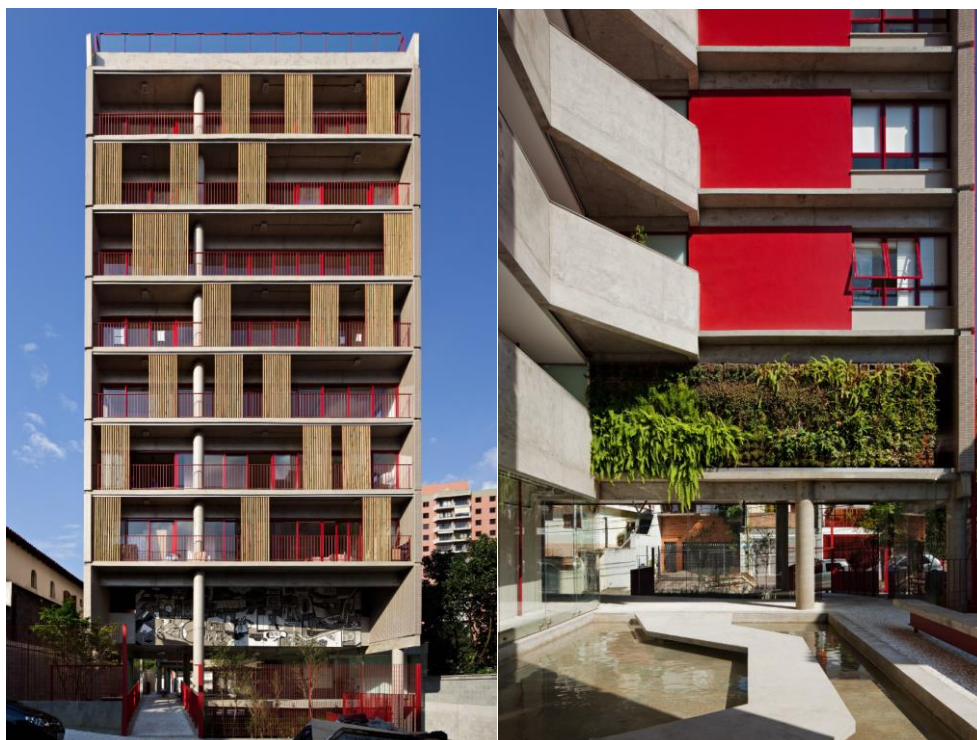
Figura 36 - Fachada principal e vista da área de lazer do edifício Simpatia 236, projeto do escritório de arquitetura Grupo SP. Fonte: Archidaily (2012).
