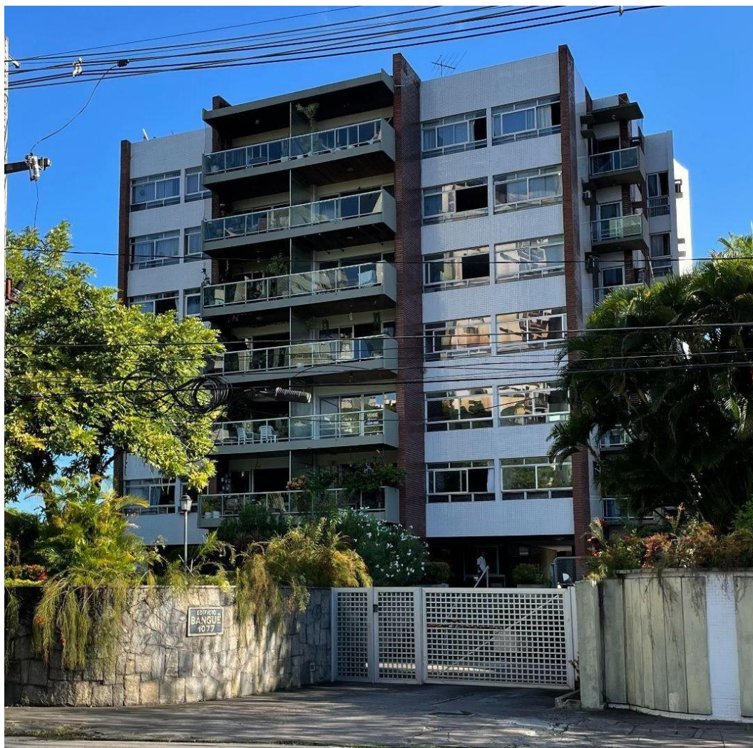
Figura 93 - Estado atual do edifício Banguê, 2023. Fonte: Acervo pessoal da autora (2023).
