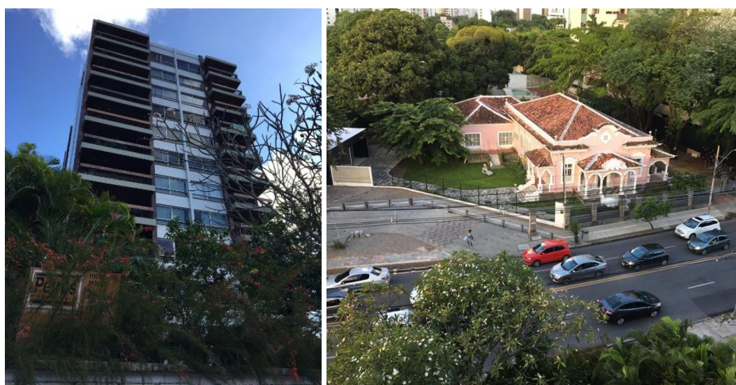
Figura 272 - Fachada do Edifício Senzala (esquerda) e campo visual do sétimo andar do edifício (direita). Fonte: Acervo pessoal da autora (2018).
