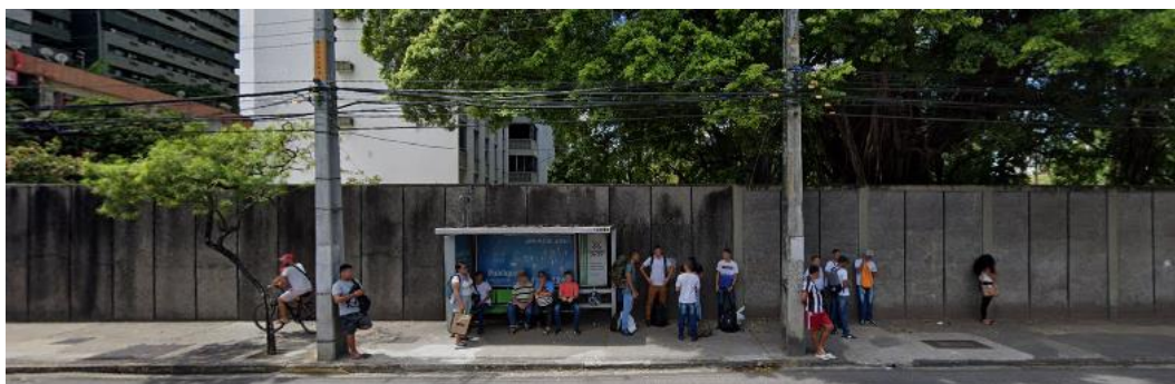
Figura 281 - Muro totalmente opaco do edifício Casa Grande Santanna, construído em 1980. Fonte: Acervo pessoal da autora (2022).
