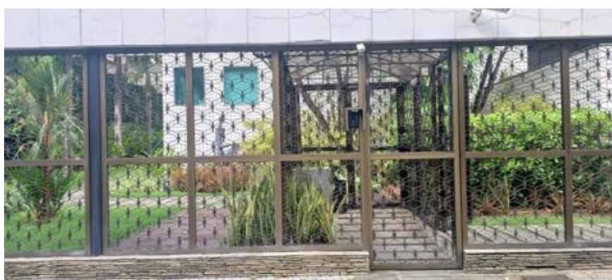
Figura 153 - Antecâmara de pedestre do Edifício Villa de Praça. Fonte: Acervo pessoal da autora (2022).
