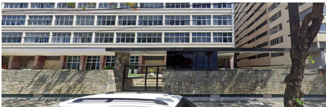
Figura 46 - Portaria do Edifício Acaiaca. Fonte: Acervo pessoal da autora (2023).
