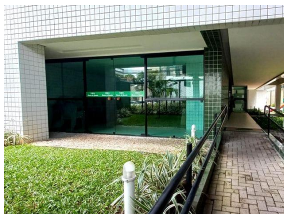
Figura 247 - Acesso ao hall social do edifício Barão de Granito. Fonte: Acervo pessoal da autora (2023).
