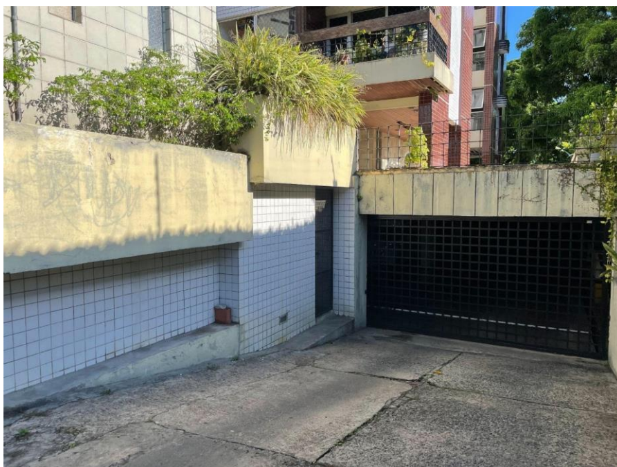
Figura 100 - Espaço destinado ao depósito da lixeira e à entrada e saída de veículos do edifício Sensala. Fonte: Acervo pessoal da autora (2023).
