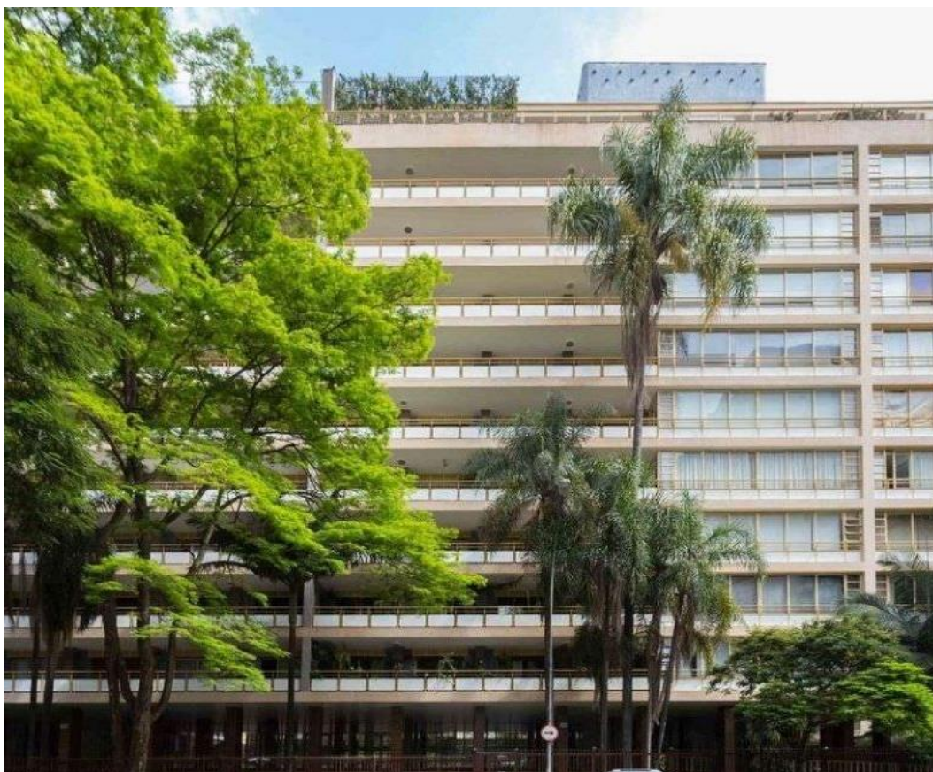
Figura 11 - Fachada frontal do Edifício Prudência. Fonte: Caprio (2007).
