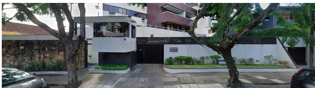
Figura 279 - Devido a altura da portaria em relação a calçada, existe pouca interação com o público. Fonte: Acervo pessoal da autora (2022).
