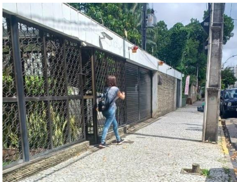
Figura 154 - Calçada e acesso do Edifício Villa de Praça. Fonte: Acervo pessoal da autora (2022).
