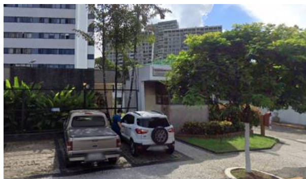
Figura 162 - Portaria do edifício Alameda Dezessete. Fonte: Acervo pessoal da autora (2023).
