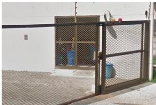
Figura 206 - Lixeira do projeto original do edifício Oliveira Santos. Fonte: Acervo pessoal da autora (2019).
