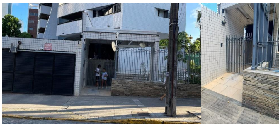
Figura 133 - Espaço de transição do edifício Freguesia de Casa Forte. Fonte: Acervo pessoal da autora (2023).
