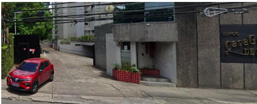
Figura 108 - e elemento de disposição de lixeira do edifício Casa Grande Santanna.
