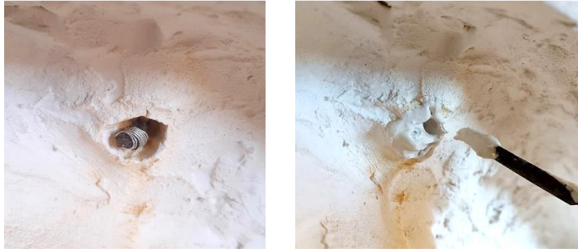
Figura 83 – À esquerda, arame de zinco galvanizado aplicado na estrutura interna; à direita, aplicação de gesso cola na estrutura interna, após a aplicação do arame. ©PSML/Mariana Figueiredo
