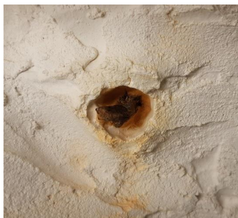
Figura 76 - Estrutura interna depois da nossa intervenção. ©PSML/Mariana Figueiredo
