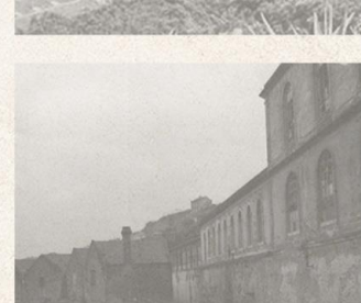
Fotografias históricas do edifício.
