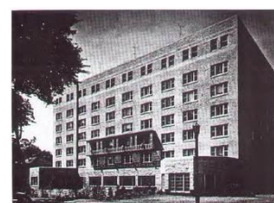
Fig.38 | Fachada principal do projeto de Childs & Smith, em Evanston.
