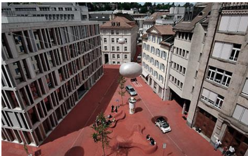
Fig. 55 | Elementos estruturais controlam a velocidade dos veículos
