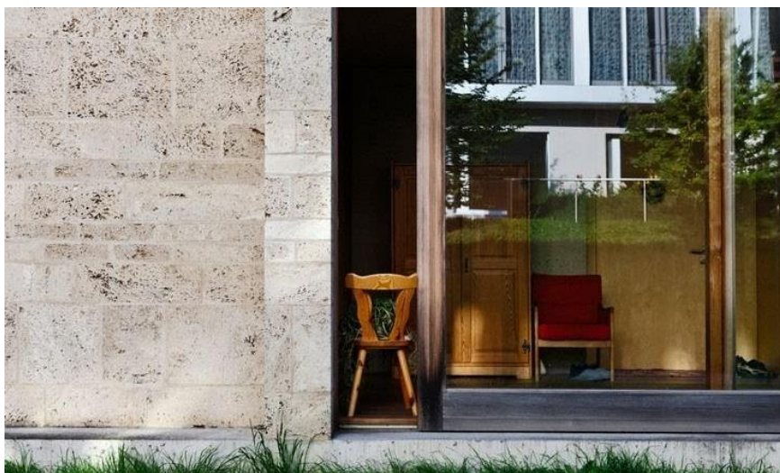
Fig. 64 | Vista exterior | Relação interior-exterior Transição da zona intermédia (corredor) para o espaço público (jardim).
