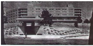
Fig.40 | Fachada principal do projeto St. Vincent
