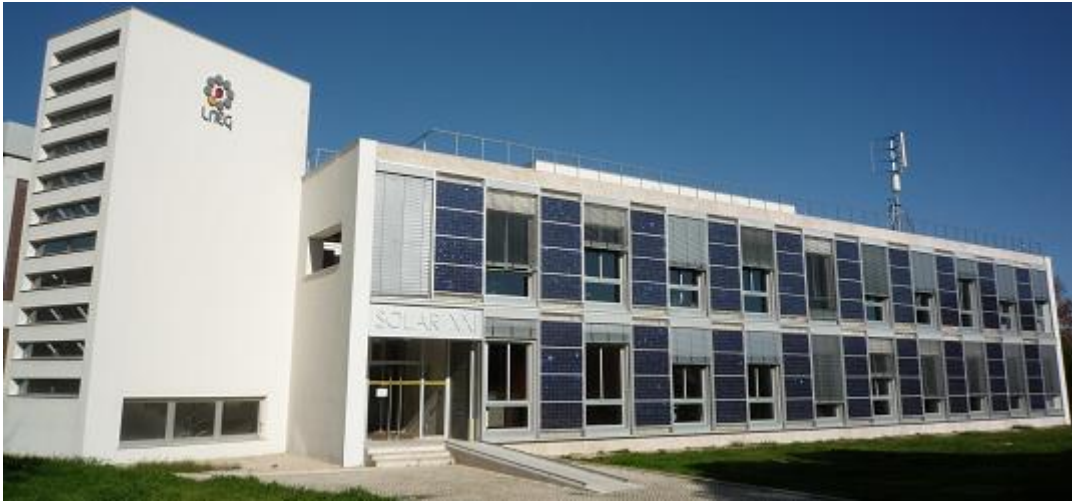
Figura 2.1. Fachada do edifício Solar XXI [21]
