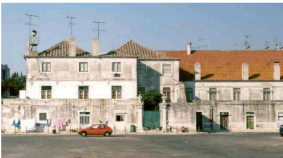
Figura 48 - Estado da Casa do Governador da Torre de Belém antes da reabilitação
