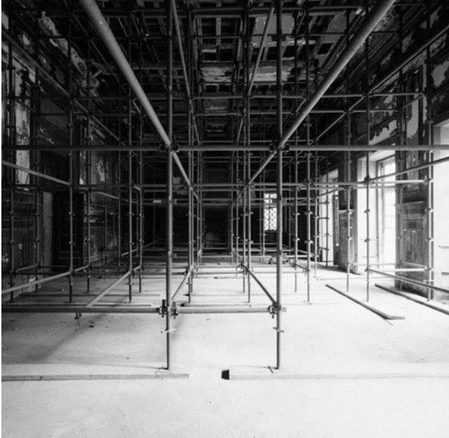
Escoramentos da Sala de Buffet
