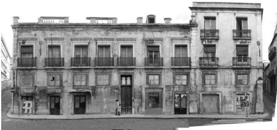
Figura 20 - Fachada principal do edifício antes da reabilitação
