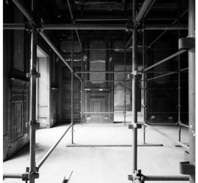
Escoramentos da Sala de Buffet
