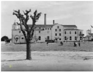
Fig. 38 – Fachada Noroeste do Convento, com vista para a Praça D. João IV
