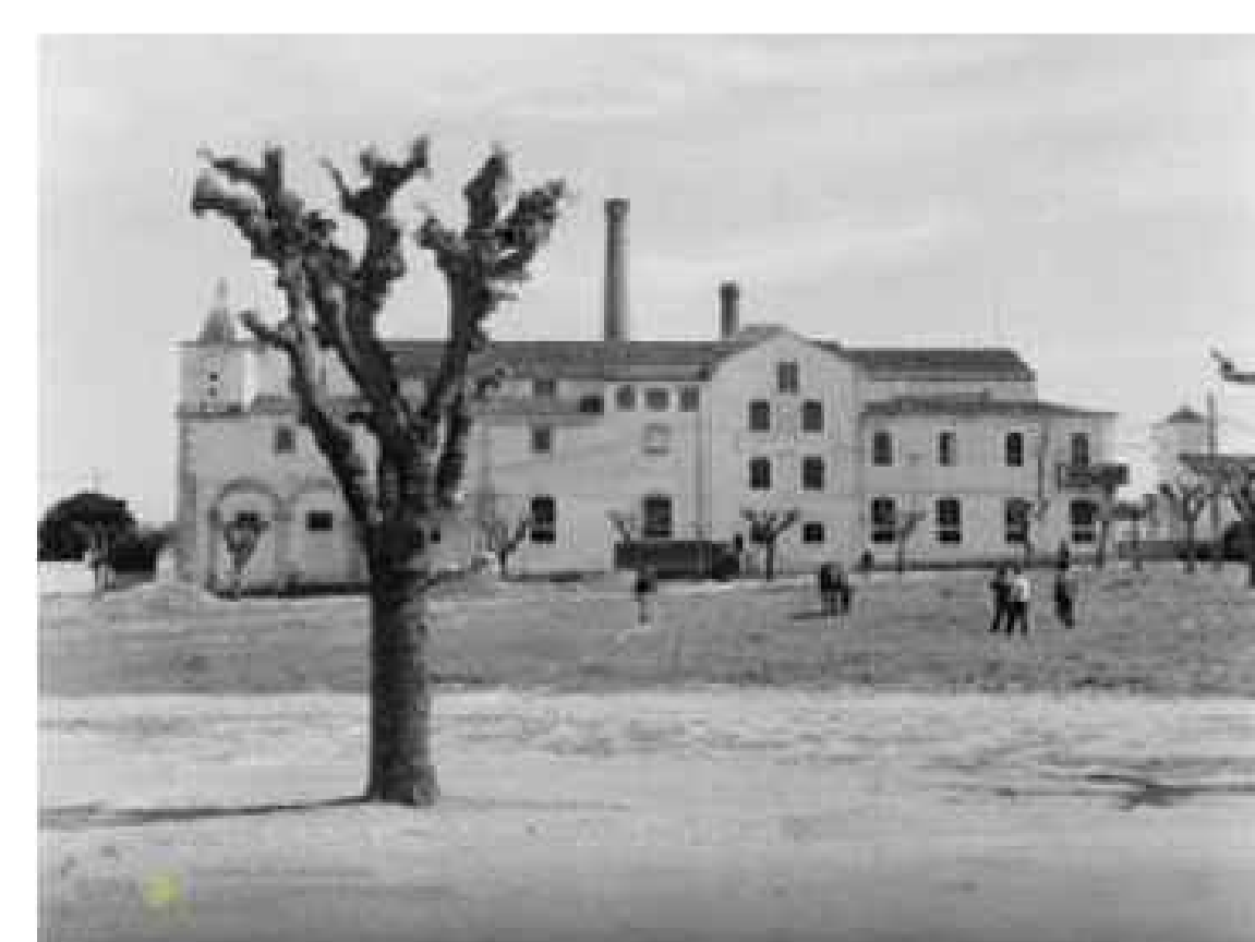
Fachada Noroeste, voltada para a Praça D. João IV
