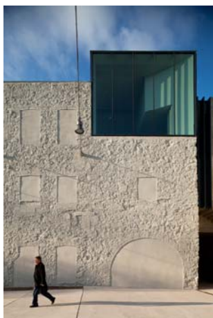
Fig. 17 - Museu Can Framis, Jordi Badia, Barcelona, Espanha
