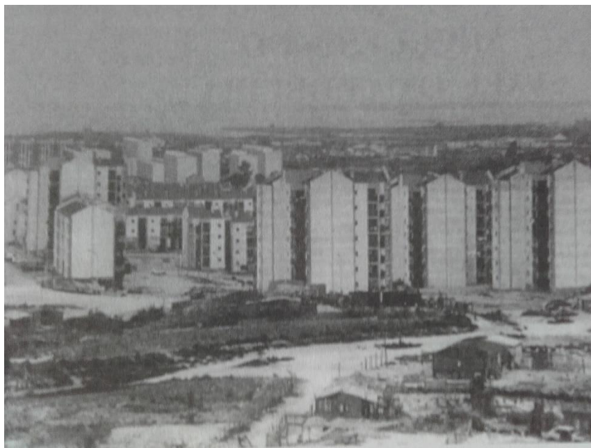
Figura 3 - Vista geral do Vale da Amoreira, antes das obras de requalificação. 48
