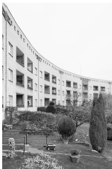
Figura 46 - Composição da fachada e espaços verdes existentes no edifício principal
