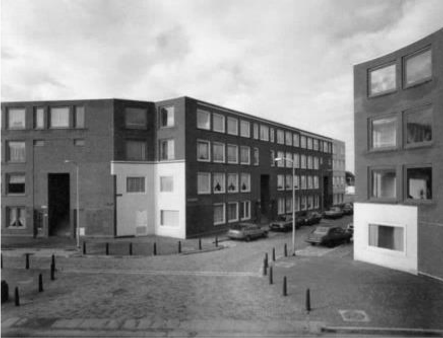
Figura 35 - Estrutura Viária e Arruamentos do Bairro
