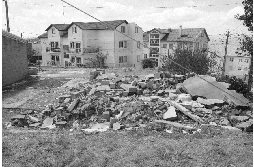
Figura 11 - Destroços da demolição das habitações
