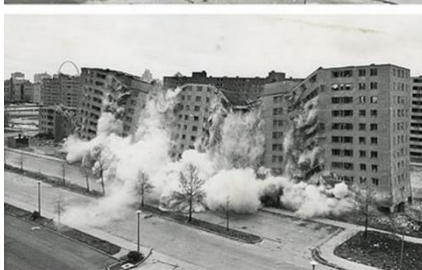
Figura 21 - Demolição do Complexo Residencial de Scampia, à direita
