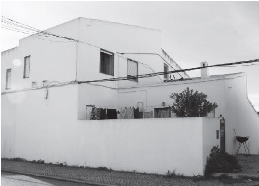
Figura 43 - Habitação na fase inicial de realojamento
