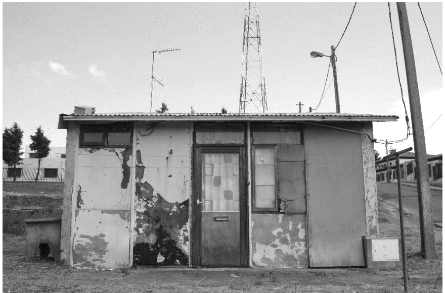
Figura 12 - Fachada de uma das moradias
