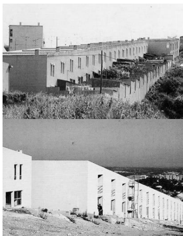
Figura 54 - Bairro do Casal das Figueiras quando foi construído
