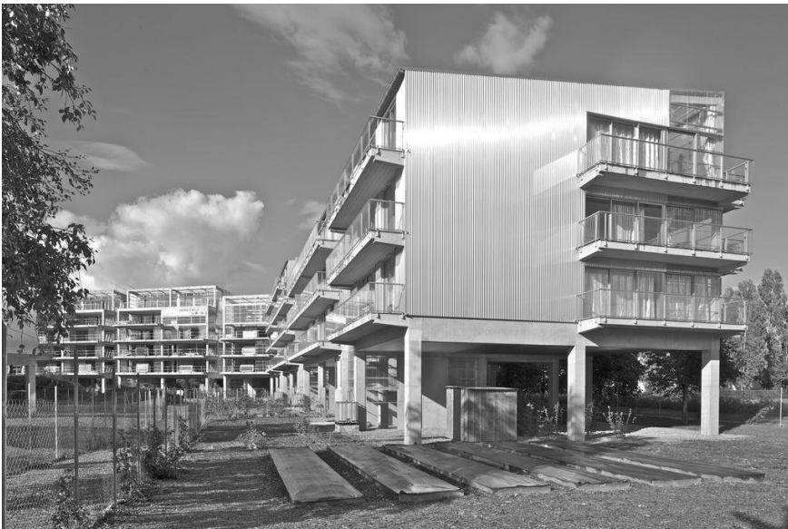
Figura 60 – Fotografia do complexo habitacional
