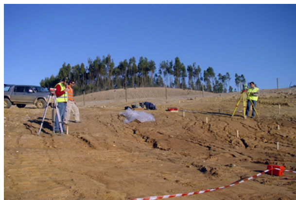
FIG. 11 Aspecto dos trabalhos em Cabeço de Palheiros 2.
