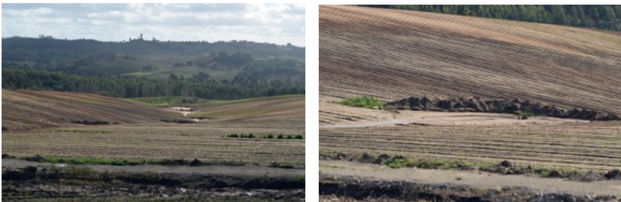
Figura 15 – Evidência de erosão na unidade de terra 12 (39°13'40.1"N 9°13'44.1"W).
