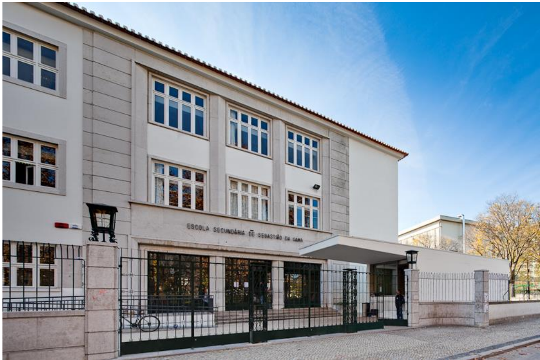
Figura 2. Escola Secundária Sebastião da Gama
