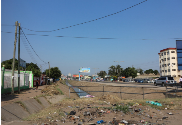
Figura 6. As infra-estruturas urbanas - do Formal ao Informal . Fonte: autora
