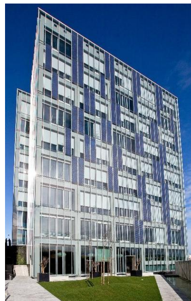
Figura 27 – Edifício que tem incorporado painéis fotovoltaicos nas fachadas, tirando benefício da orientação solar. Natura Towers, Lumiar, Lisboa.
