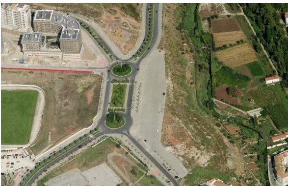
Figura 74 – Área de intervenção - zona do pavilhão – vista aérea.
