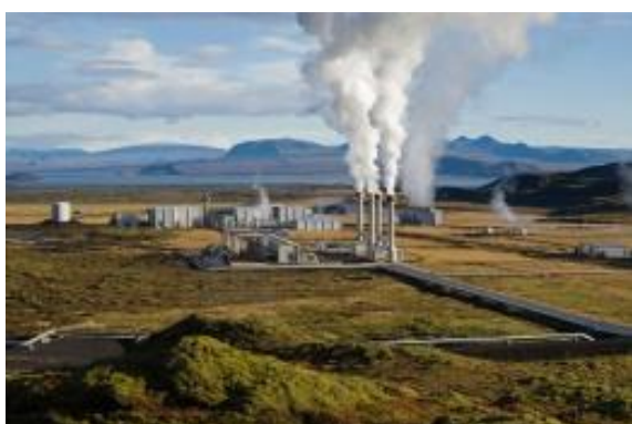
Figura 13 – Central para aproveitamento de energia geotérmica em Nesiavellir, Islândia.
