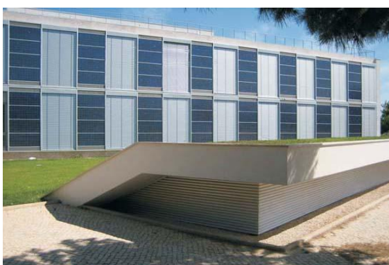
Figura 62 – Aspecto exterior do poço de admissão de ar com grelha contínua – Edifício Solar XXI.
