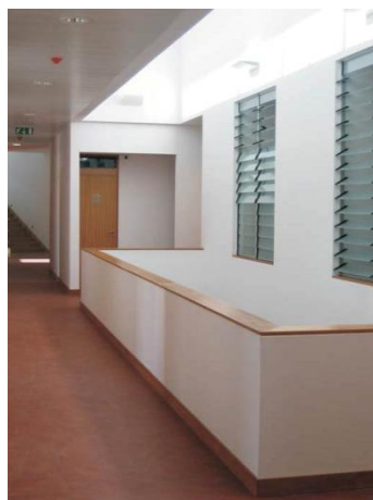
Figura 57 – Corredor de distribuição e vãos interiores translúcidos de lâminas reguláveis – Edifício Solar XXI.
