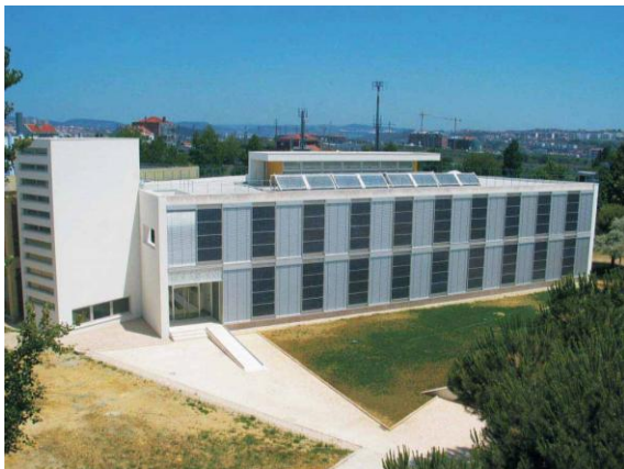
Figura 50 – Vista geral da fachada Sul – Edifício Solar XXI.
