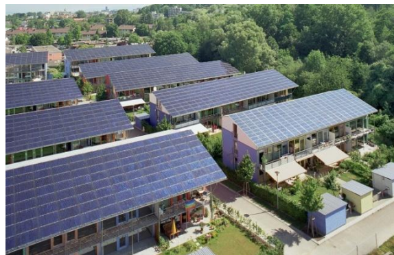
Figura 20 – Edifícios com incorporação na cobertura de sistemas de captação de energia solar. Vila solar, Freiburg, Alemanha.
