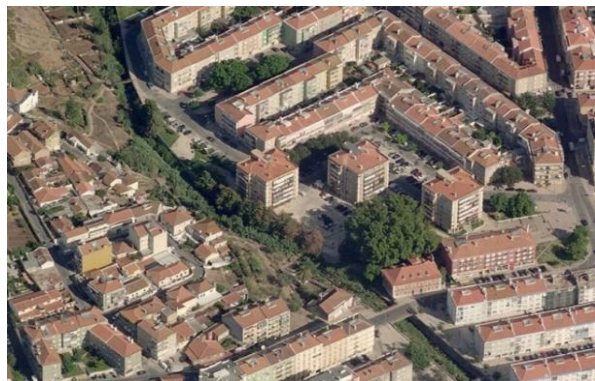
Figura 75 – Área de intervenção - zona dos Pombais – vista aérea.
