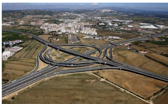
Figura 17 – Infra-estruturas rodoviárias que permitem uma grande mobilidade ao ser humano. Carregado, Portugal.
