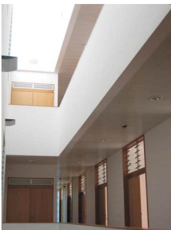
Figura 56 – Vazio central para iluminação e ventilação – Edifício Solar XXI.
