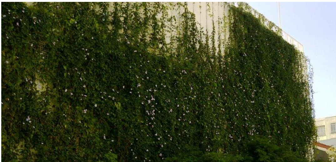
Figura 4. Fachada verde indireta em treliças modulares. (Fonte: Ecotelhado, 2025)
