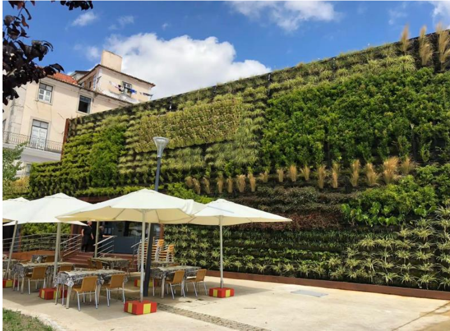
Figura 3. Parede viva modular nas fachadas do restaurante “Valenciana” em Campolide, Lisboa. (Fonte: TERRACEL, 2016)
