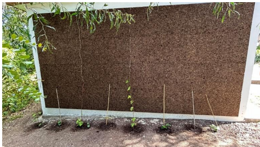
Figura 25. Fachada Este após a colocação de uma fração das guias, dia 19/04/2024.
