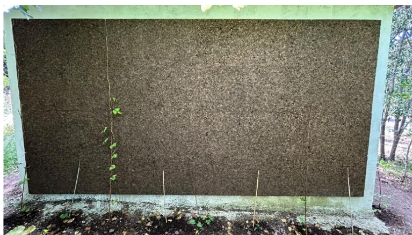
Figura 24. Fachada Este após a colocação de uma fração das guias, dia 19/04/2024.
