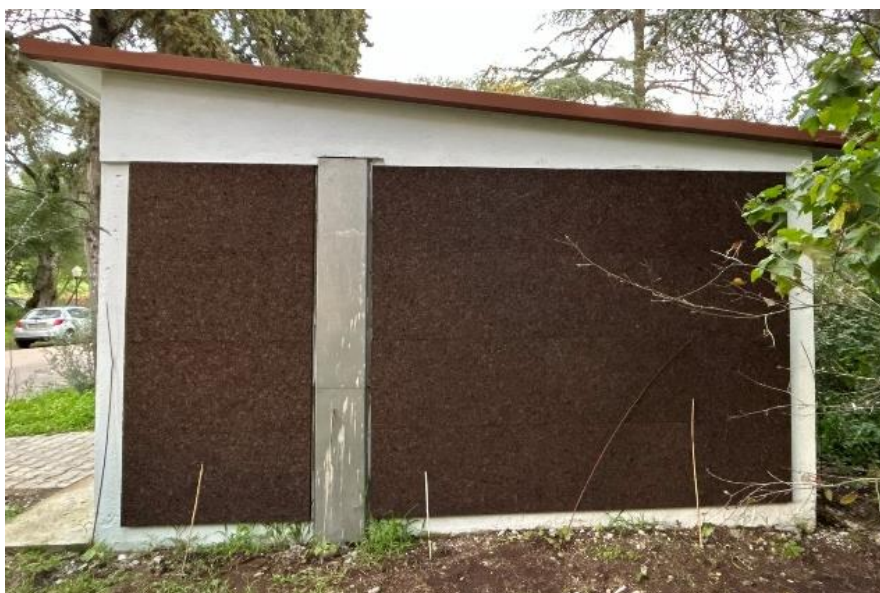
Figura 20. Fachada Sul no dia da colocação dos painéis 12/03/2024.
