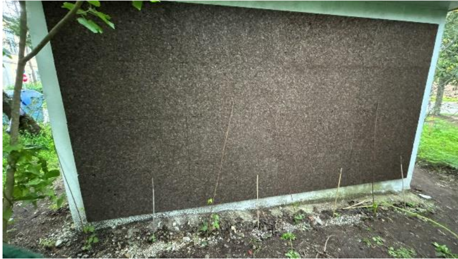
Figura 21. Fachada Este no dia da colocação dos painéis 12/03/2024.
