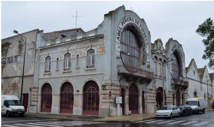
Fig. 77 Edifício pertencente ao conjunto industrial da antiga Sociedade Abel Pereira da Fonseca, S.A.R.L.
