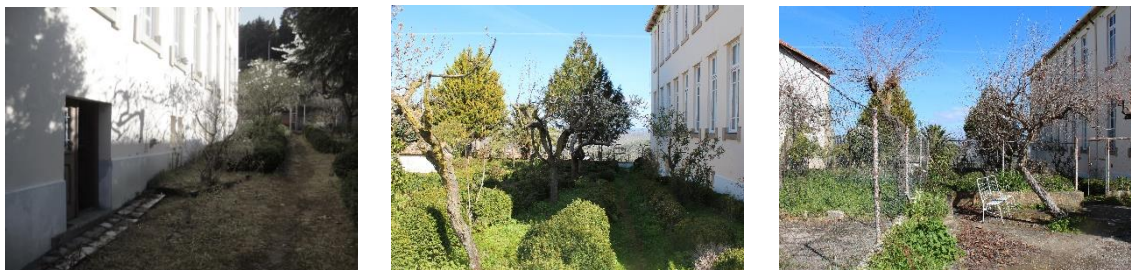
Fig. 63 - Espaço exterior compreendido entre a igreja e o asilo
