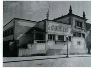
Estação de Santo Tirso, 1943 (AHFPC)
