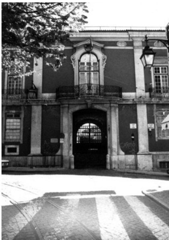
Fig. 7 - Fotografia arquivo do antigo edifício da Escola.
