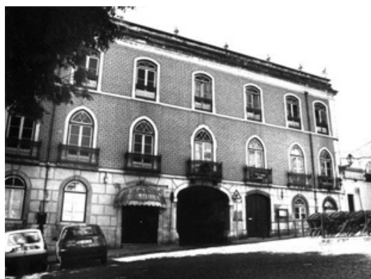
Fig. 6 - Fotografia arquivo do antigo edifício da Escola.
