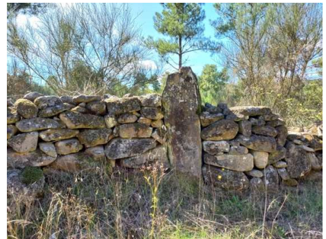
220 a 222. Diferentes tipos de colocação de pedras em muros.
