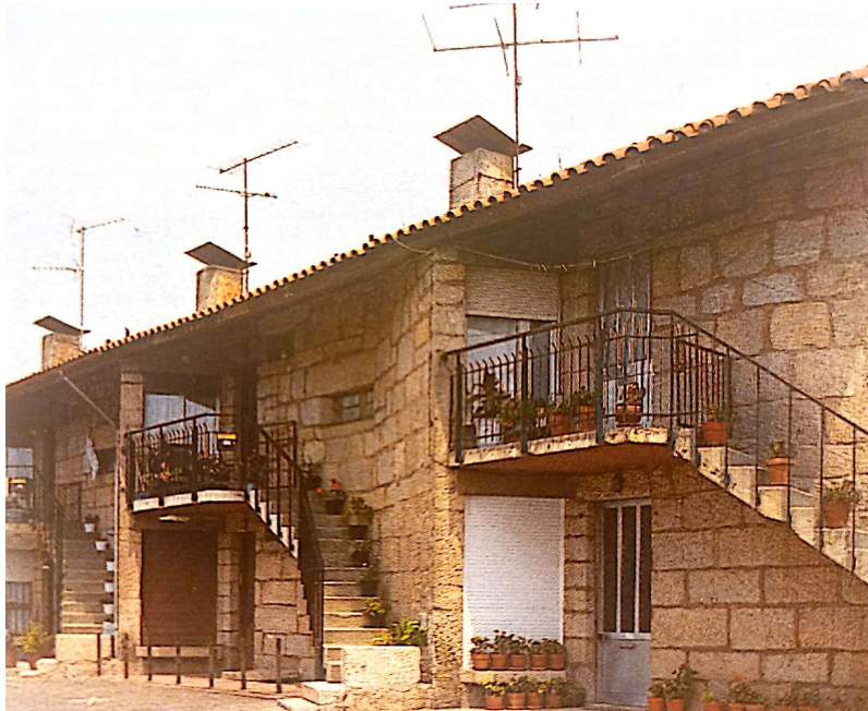
120. Vista exterior parcial do conjunto.
