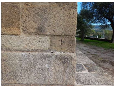
223 a 226. Marcações nas pedras.
