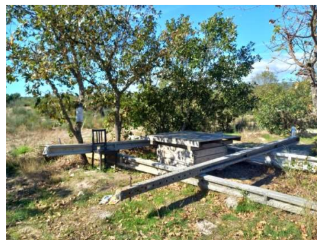
269. Estrutura abandonada e inacabada do lar de idosos. 270. Campo de futebol em construção. 271. Materiais empilhados do antigo estaleiro.
