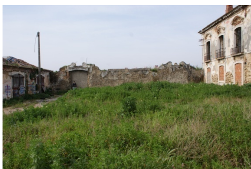
Fig.14 – Portões do Pátio de honra a Nascente
