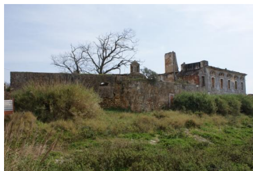
Fig.17 – Construção adossada ao muro Nascente
