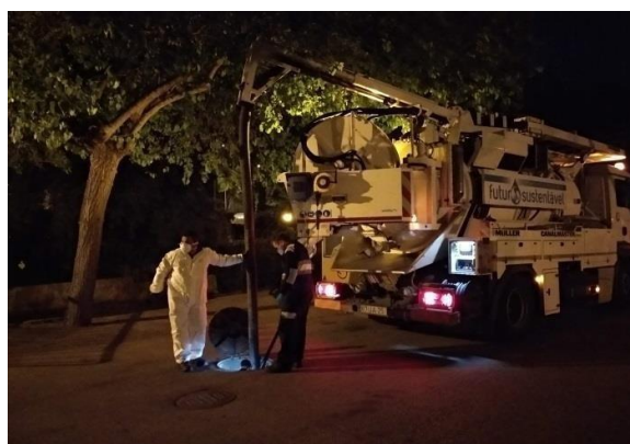
Figura 4 - Análise ergonômica da tarefa durante um turno noturno de desobstrução e manutenção de redes
