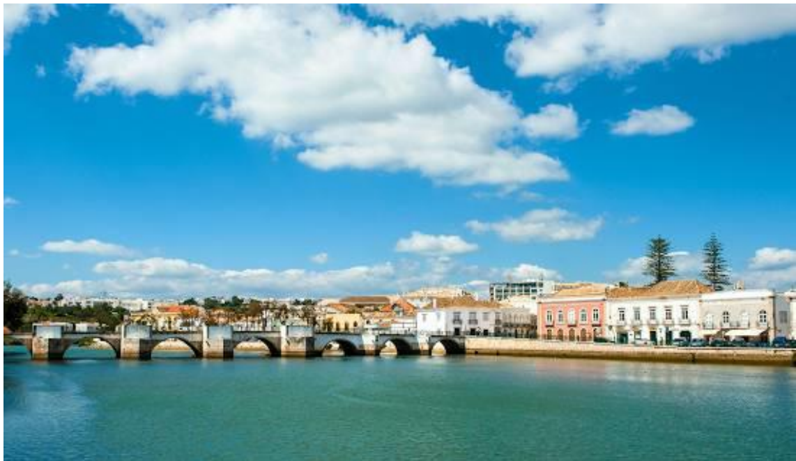
Figura 53 - Ponte de Tavira, fotografia de Shutterstock, Anyaivanova, data desconhecida.
