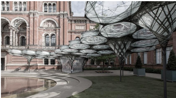
Figura 5 - Elytra Filament Pavilion, instalado no museu V&A, demonstra o potencial futuro dos sistemas construtivos com fibra de carbono, fotografia de Jessica Mairs, 2016.
