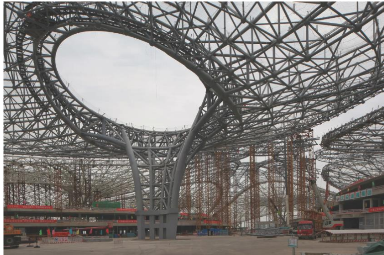
Figura 79 - Aeroporto de Beijing Daxing durante a construção, estrutura tridimensional fotografia de Beijing Institute of Architectural Design, 2019.
