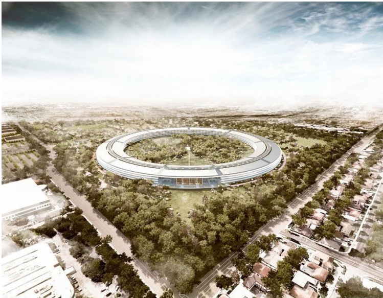
Figura 72 - Renderização de Apple Park, imagem de Foster + Partners, ARUP, Kier + Wright, Apple, projeto de 2018.
